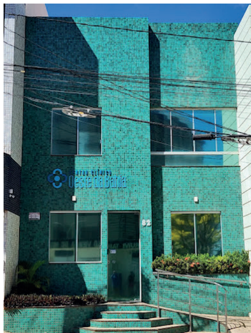
Centro Clínico Oeste da Bahia
