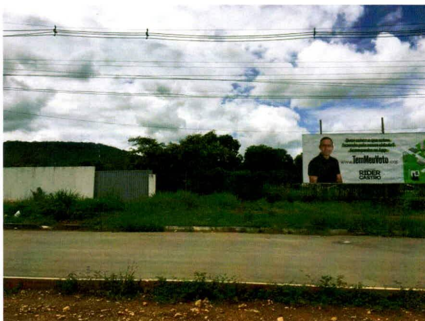
FOTOGRAFIA 18 - FACHADA UNEB, CONFRONTAMENTO COM IMÓVEL VIZINHO - (AV. ACM - VIA MARGINAL - BR-242)
