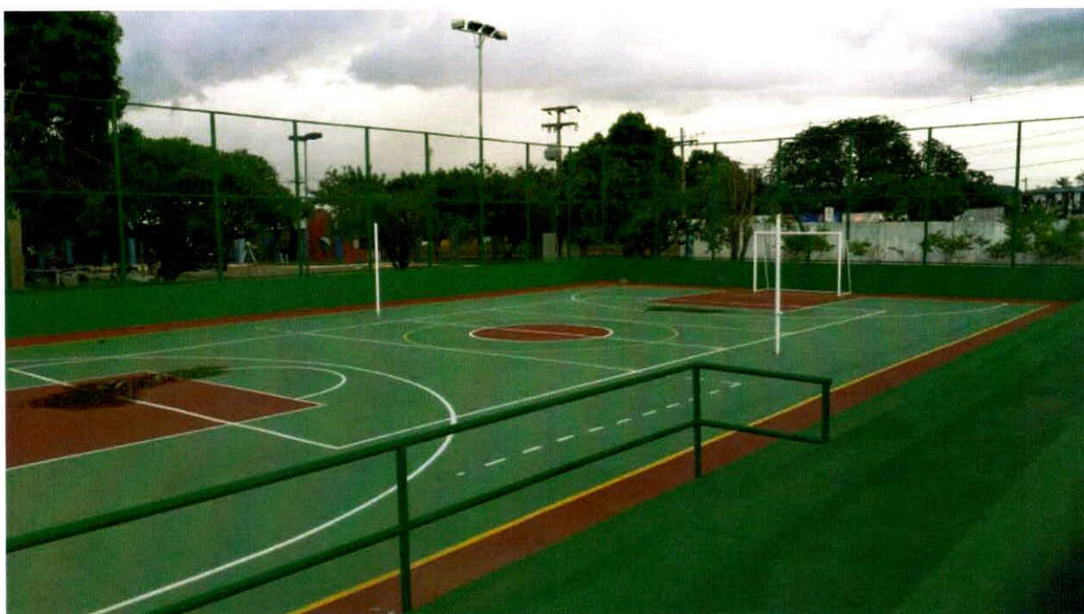
FOTOGRAFIA 61 - VISTA INTERNA CETEP PANORÂMICA QUADRA
