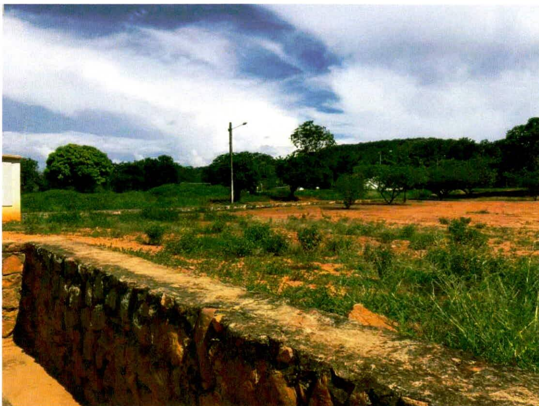
FOTOGRAFIA 35 - VISTA INTERNA UNEB - ACESSO DE PEDESTRES
