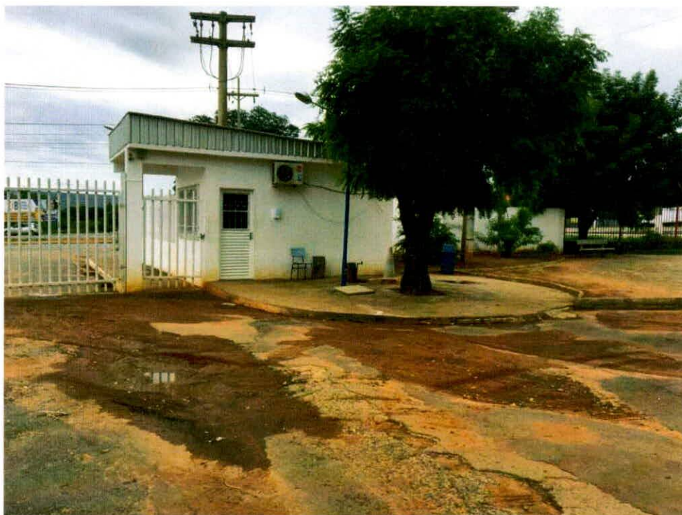
FOTOGRAFIA 39 - VISTA INTERNA UNEB - GUARITA
