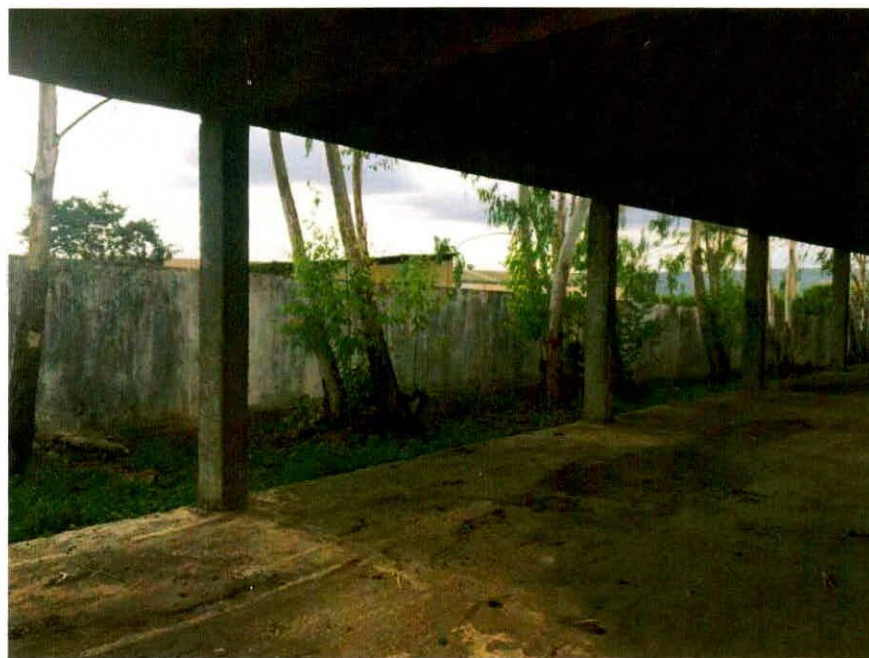
FOTOGRAFIA 44 - VISTA INTERNA CETEP PARA AV. FLUMINENSE
