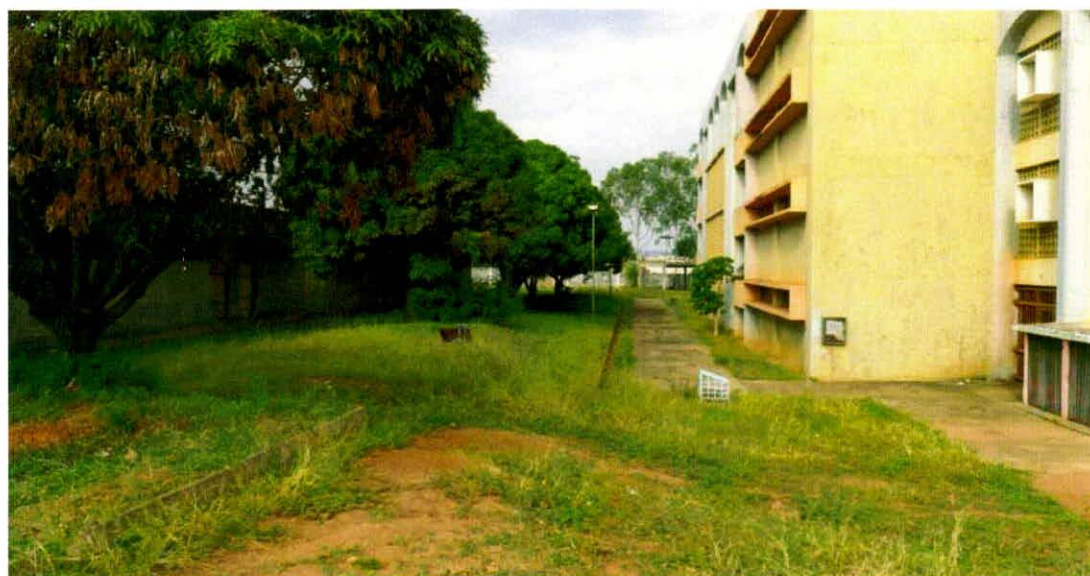
FOTOGRAFIA 54 - VISTA INTERNA CETEP VISTA MÓDULOS INACABADOS E PANORÂMICA FUNDO DO PRÉDIO PRINCIPAL
