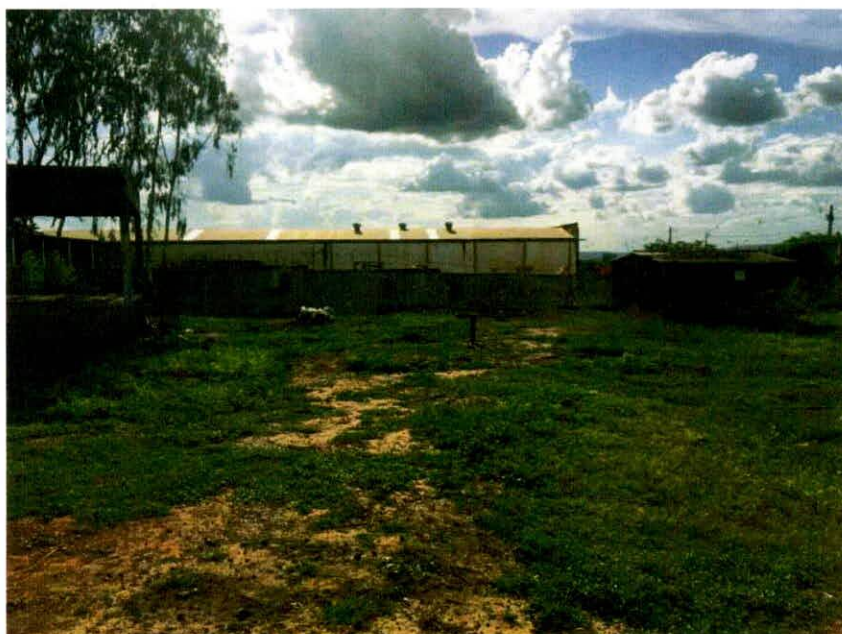
FOTOGRAFIA 43 - VISTA INTERNA CETEP PARA AV. FLUMINENSE
