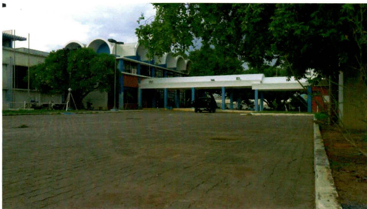
FOTOGRAFIA 64 - VISTA INTERNA CETEP PANORÂMICA ESTACIONAMENTO COM ACESSO PRINCIPAL AO PRÉDIO AO FUNDO
