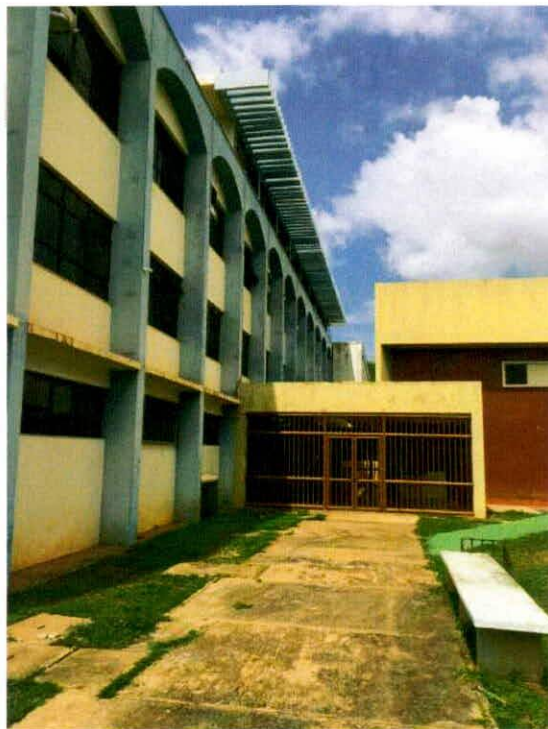
FOTOGRAFIA 56 - VISTA INTERNA CETEP VISTA LATERAL PRÉDIO PRINCIPAL
