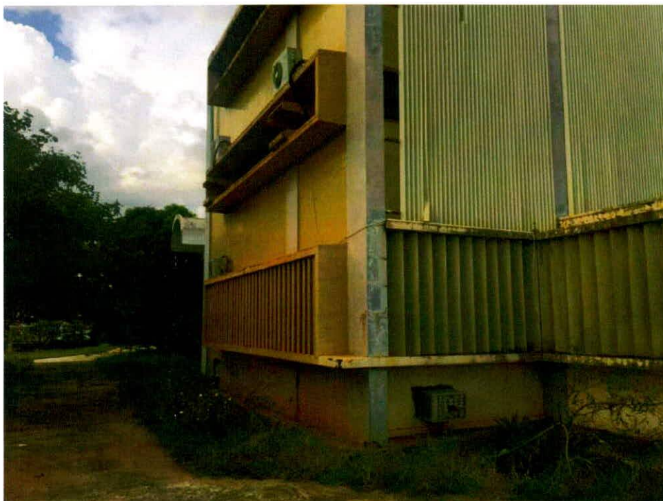
FOTOGRAFIA 46 - VISTA INTERNA CETEP VISTA LATERAL, PRÉDIO PRINCIPAL
