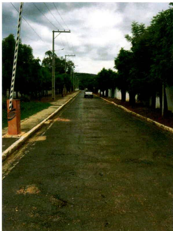
FOTOGRAFIA 40 - VISTA INTERNA UNEB - ACESSO DE VEÍCULOS
