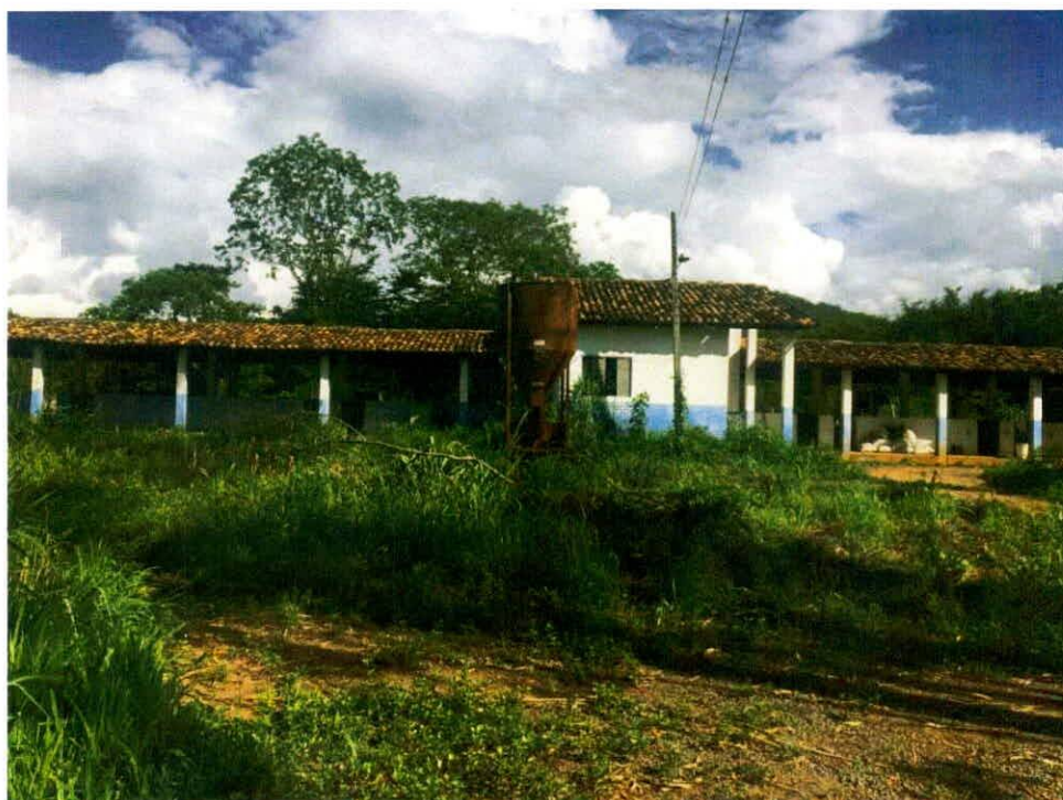
FOTOGRAFIA 26 - VISTA INTERNA UNEB - POCILGA AO FUNDO DA POLIGONAL
