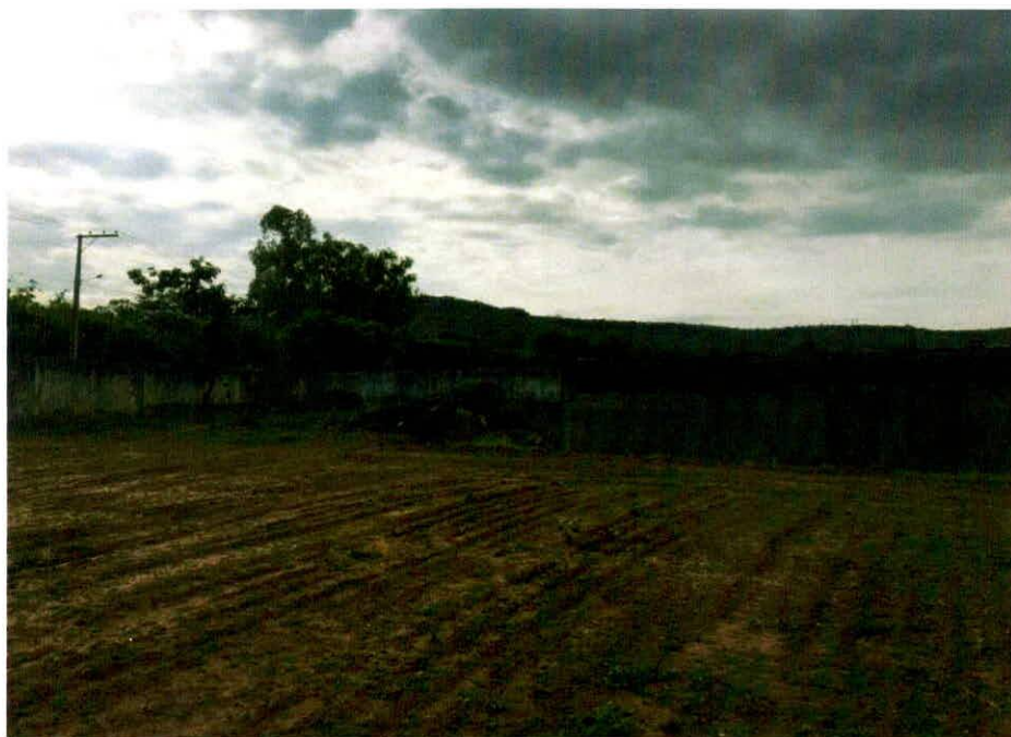
FOTOGRAFIA 52 - VISTA INTERNA CETEP VISTA MURO DIVISA COM UNEB A ESQUERDA E MURO DE DIVISA AO FUNDO COM TERRENO
