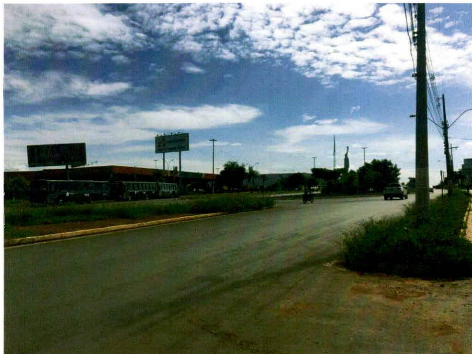
FOTOGRAFIA 20 - VISTA PANORÂMICA AV.ACM - MARGINAL - BR-242
