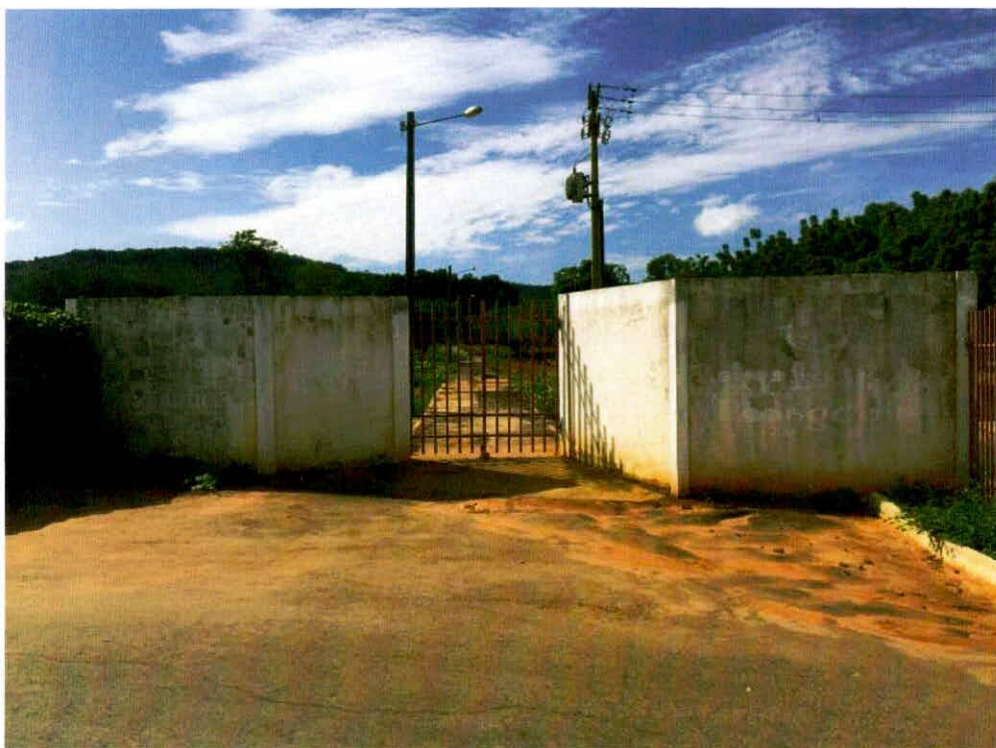
FOTOGRAFIA 16 - FACHADA UNEB ACESSO PEDESTRE - (AV. ACM - VIA MARGINAL - BR-242)
