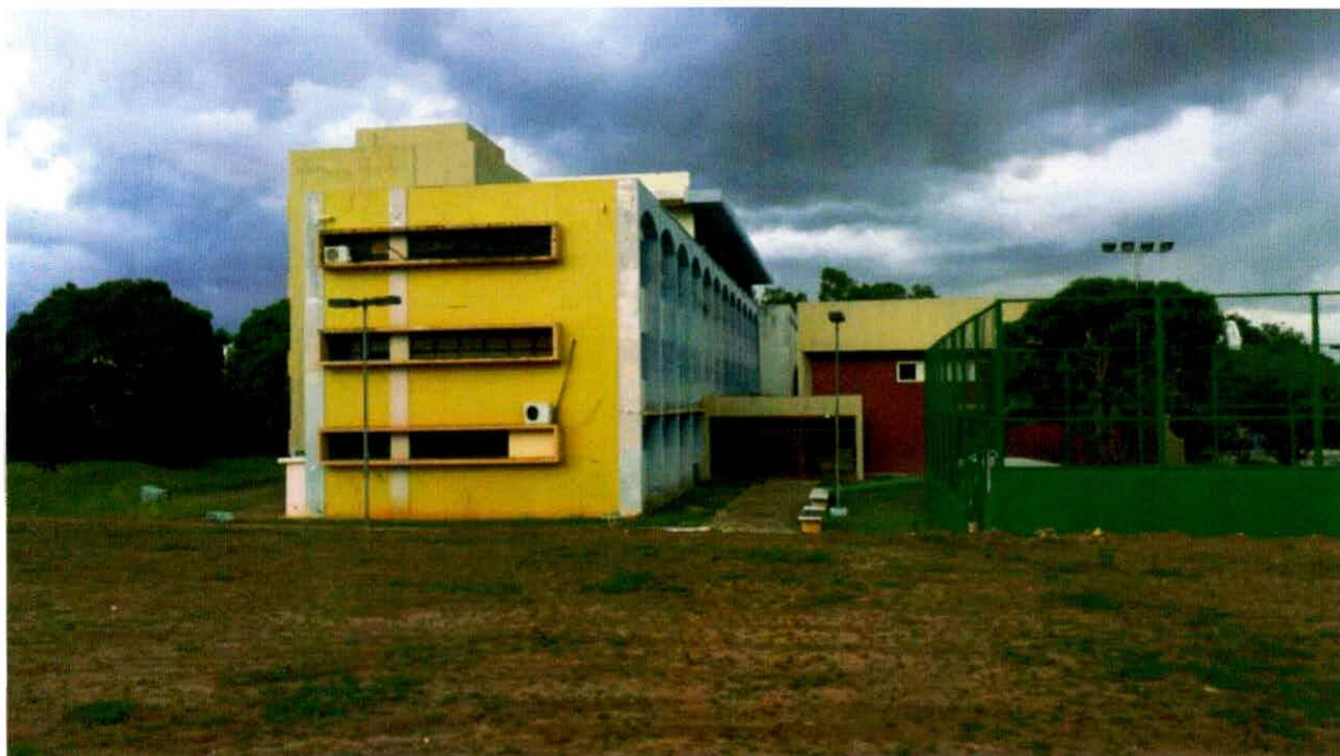
FOTOGRAFIA 55 - VISTA INTERNA CETEP VISTA LATERAL PRÉDIO PRINCIPAL E QUADRA
