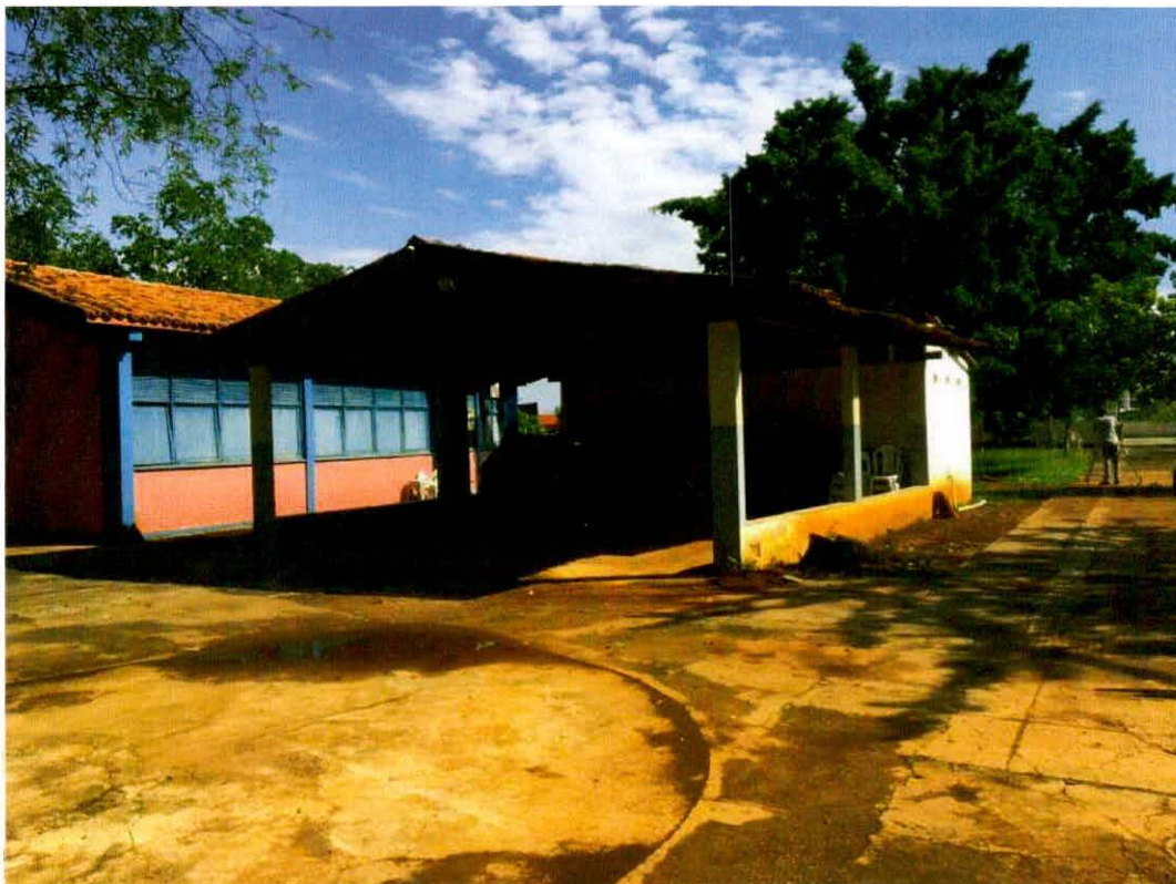
FOTOGRAFIA 31 - VISTA INTERNA UNEB - ÁREA ENTRE OS MÓDULOS, VISTA DA CANTINA NO ALINHAMENTO DA POLIGONAL
