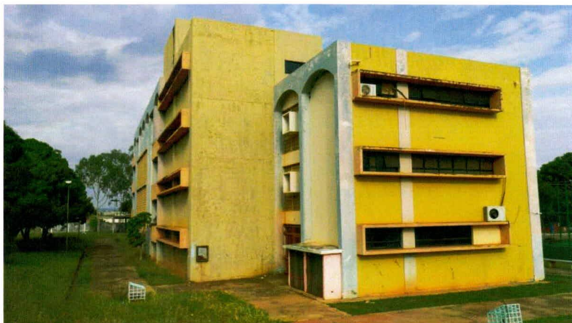
FOTOGRAFIA 49 - VISTA INTERNA CETEP VISTA LATERAL, PRÉDIO PRINCIPAL
