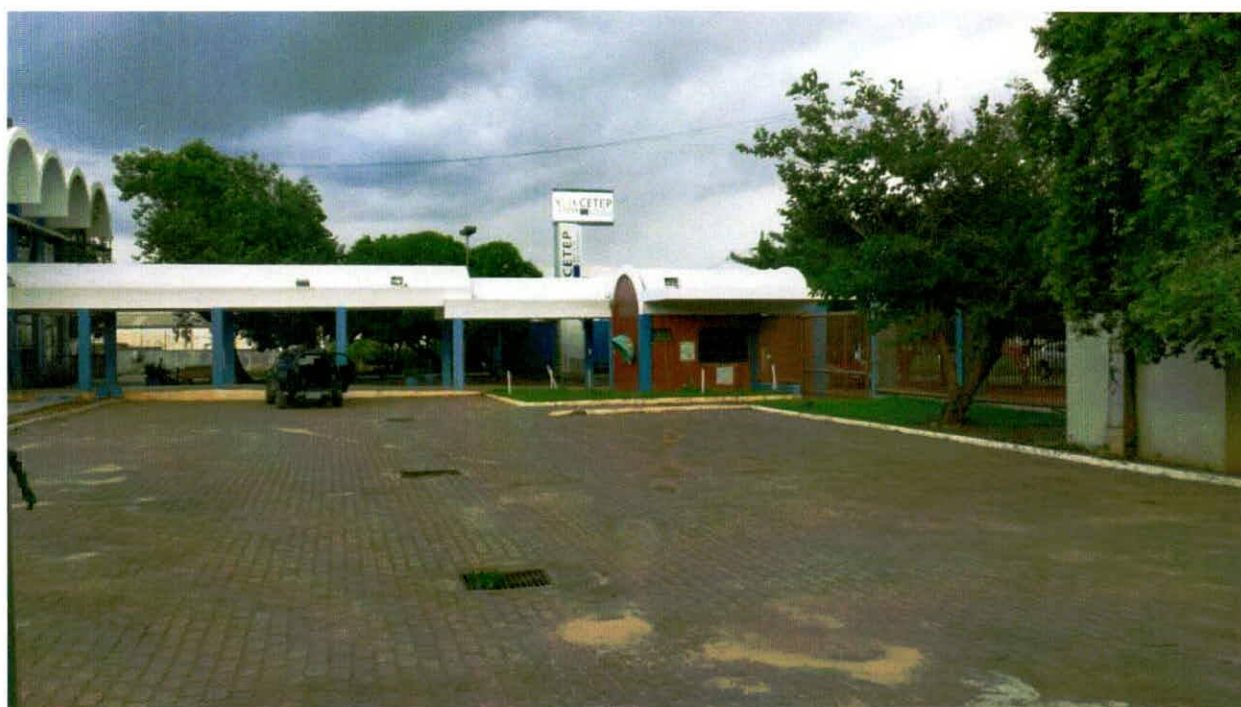
FOTOGRAFIA 66 - VISTA INTERNA CETEP PANORÂMICA ESTACIONAMENTO COM ACESSO PRINCIPAL AO PRÉDIO AO FUNDO, ENTRADA DE VEÍCULOS E GUARITA
