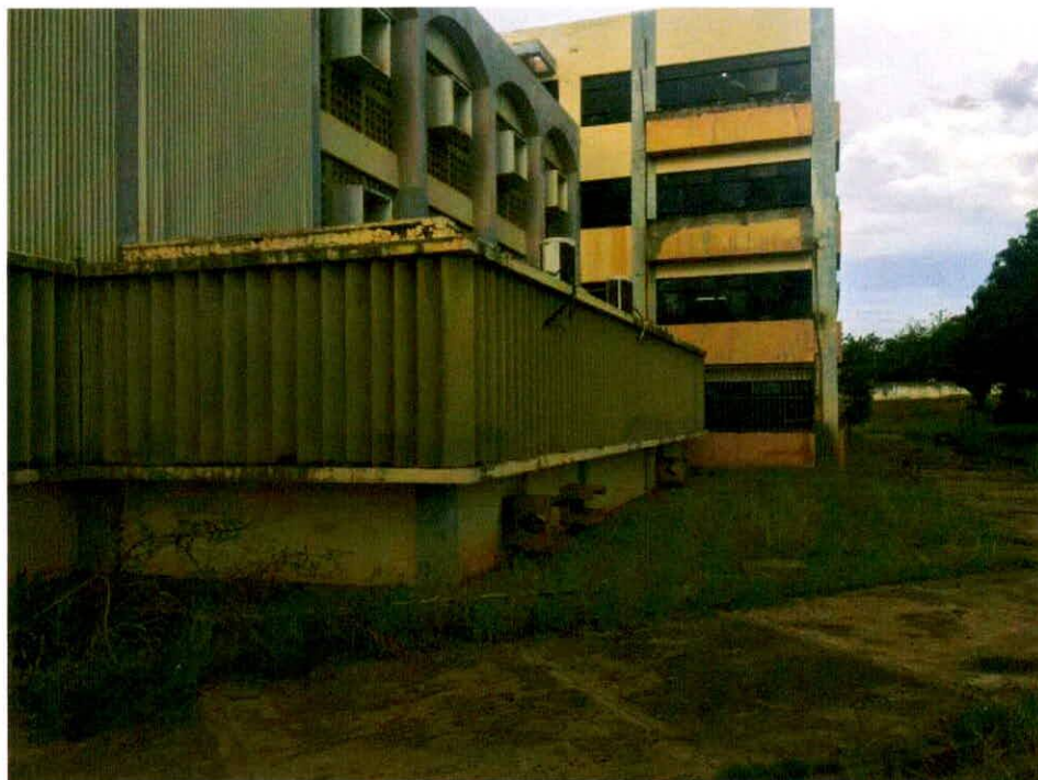
FOTOGRAFIA 47 - VISTA INTERNA CETEP VISTA FUNDOS, PRÉDIO PRINCIPAL
