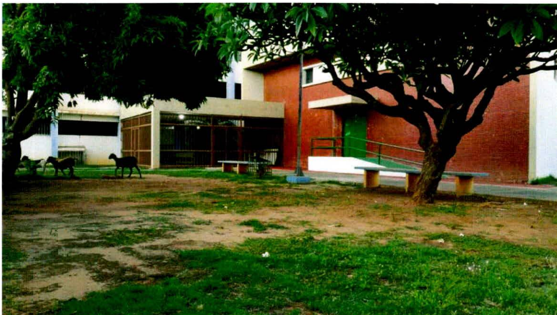
FOTOGRAFIA 57 - VISTA INTERNA CETEP VISTA ANFITEATRO
