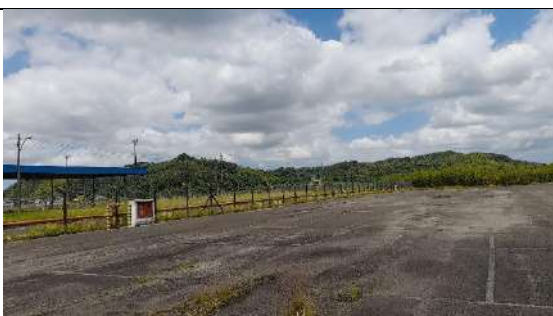
Figura 11 – Pátio e cercamento
