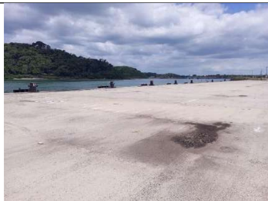
Figura 10 – Cais de estacas
