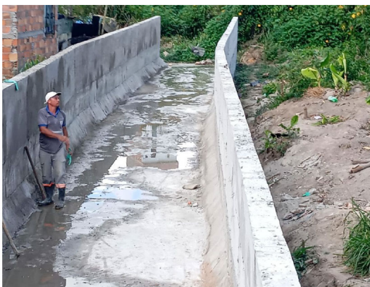
Interior do canal concluído – seção acabada.
