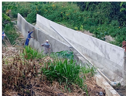
Vista geral do canal de macrodrenagem executado.
