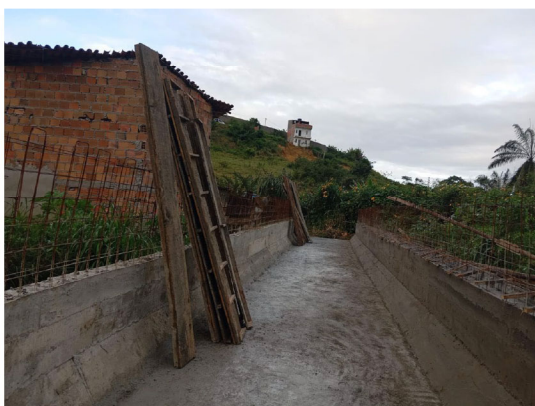
Trecho do canal de macrodrenagem concretado (seção BSCC).
