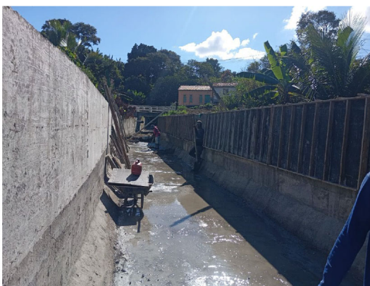
Canal de macrodrenagem executado – vista ampla.
