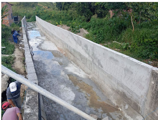
Canal de macrodrenagem concluído – trecho executado.
