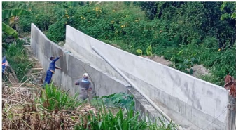
Trecho do canal de macrodrenagem concretado (seção BSCC).
