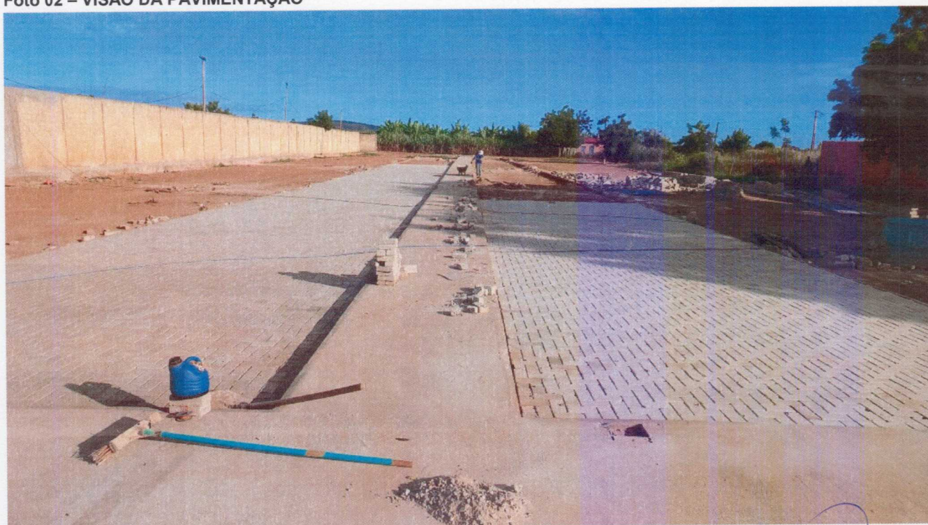
Foto 02 – VISÃO DA PAVIMENTAÇÃO
