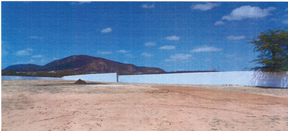
Foto 01 – VISTA GERAL DO MURO.
