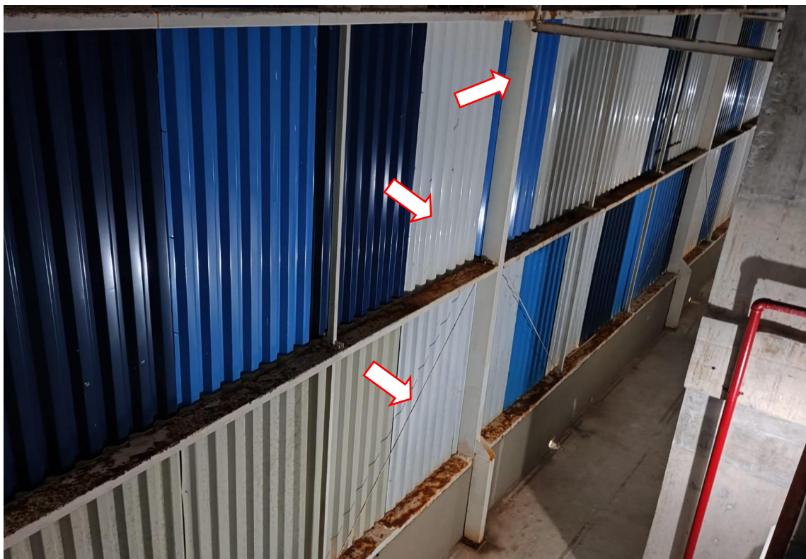
IMAGEM 2 – Elementos da Estrutura Metálica do Fechamento Lateral
