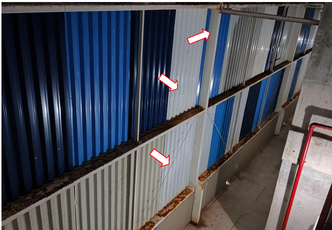
IMAGEM 2 – Elementos da Estrutura Metálica do Fechamento Lateral
