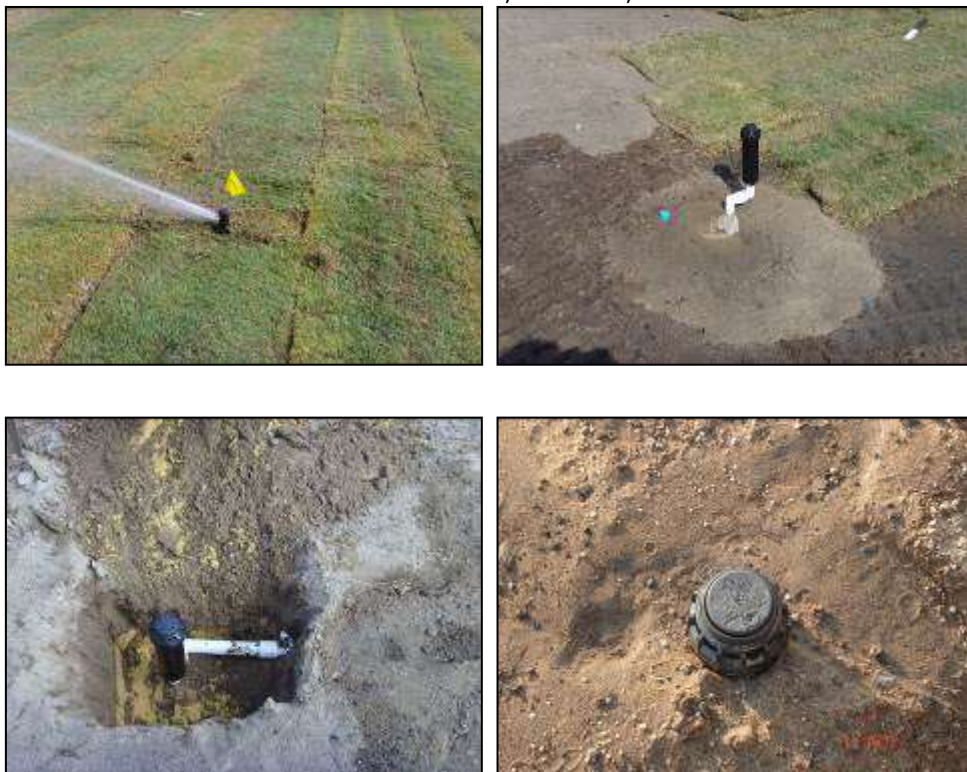
Detalhes dos aspersores no gramado
