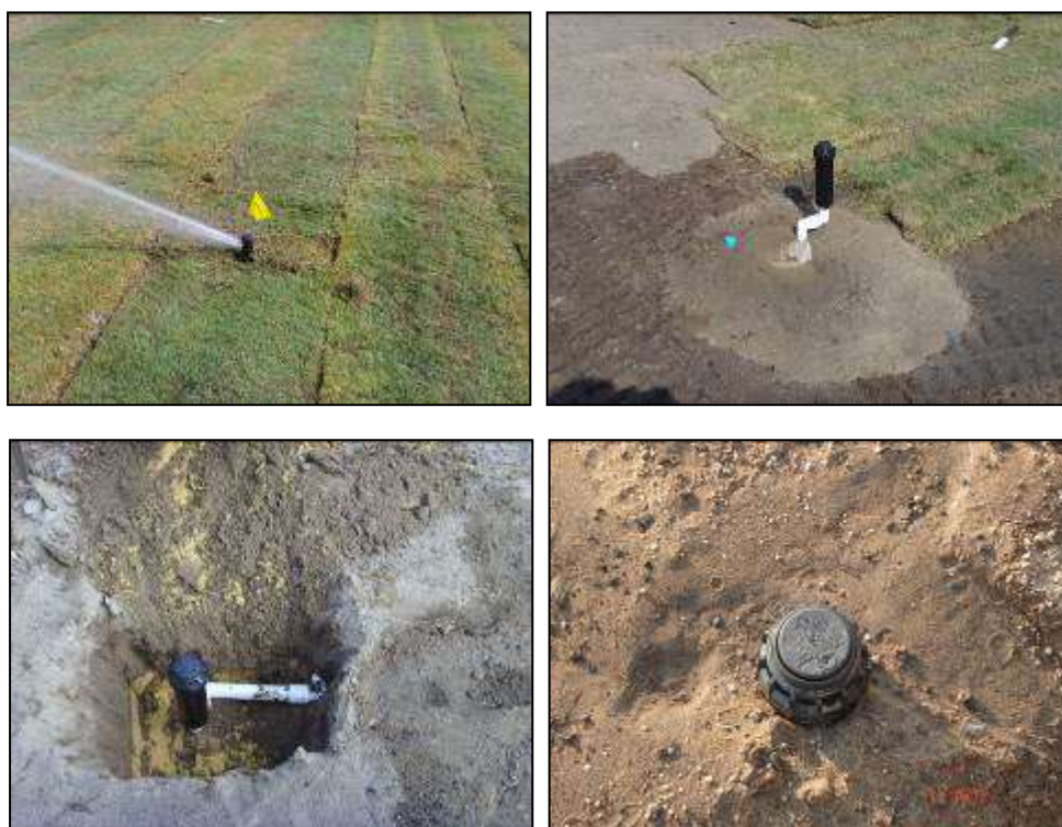
Detalhes dos aspersores no gramado
