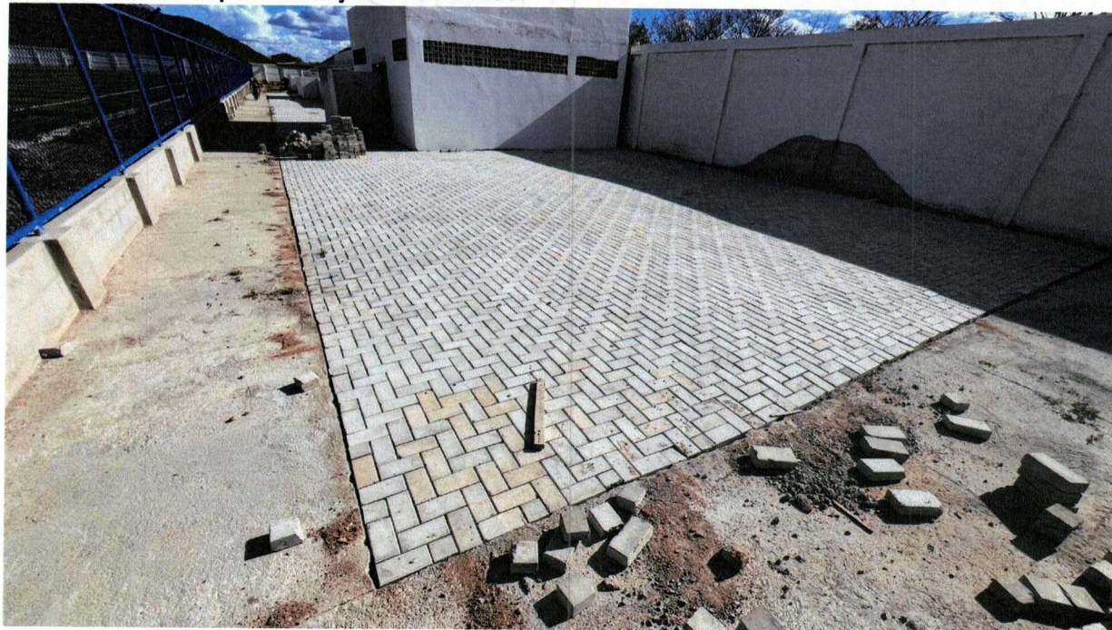
FOTO 03 - Vista da pavimentação intertravado.
