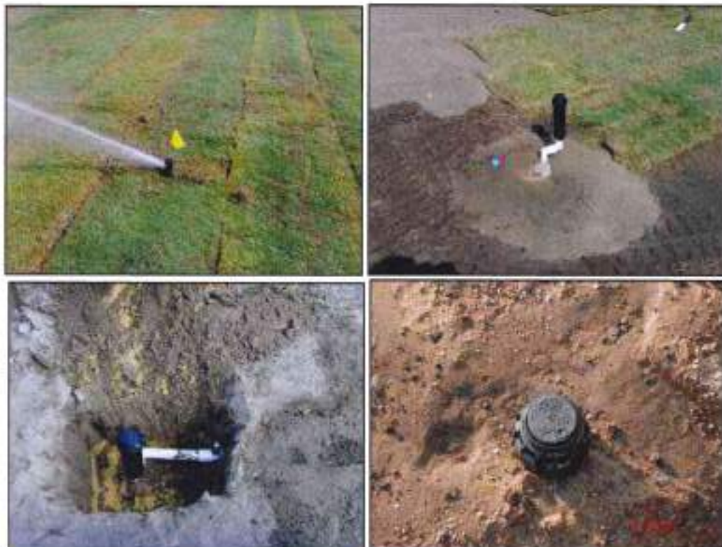
Detalhes dos aspersores no gramado
