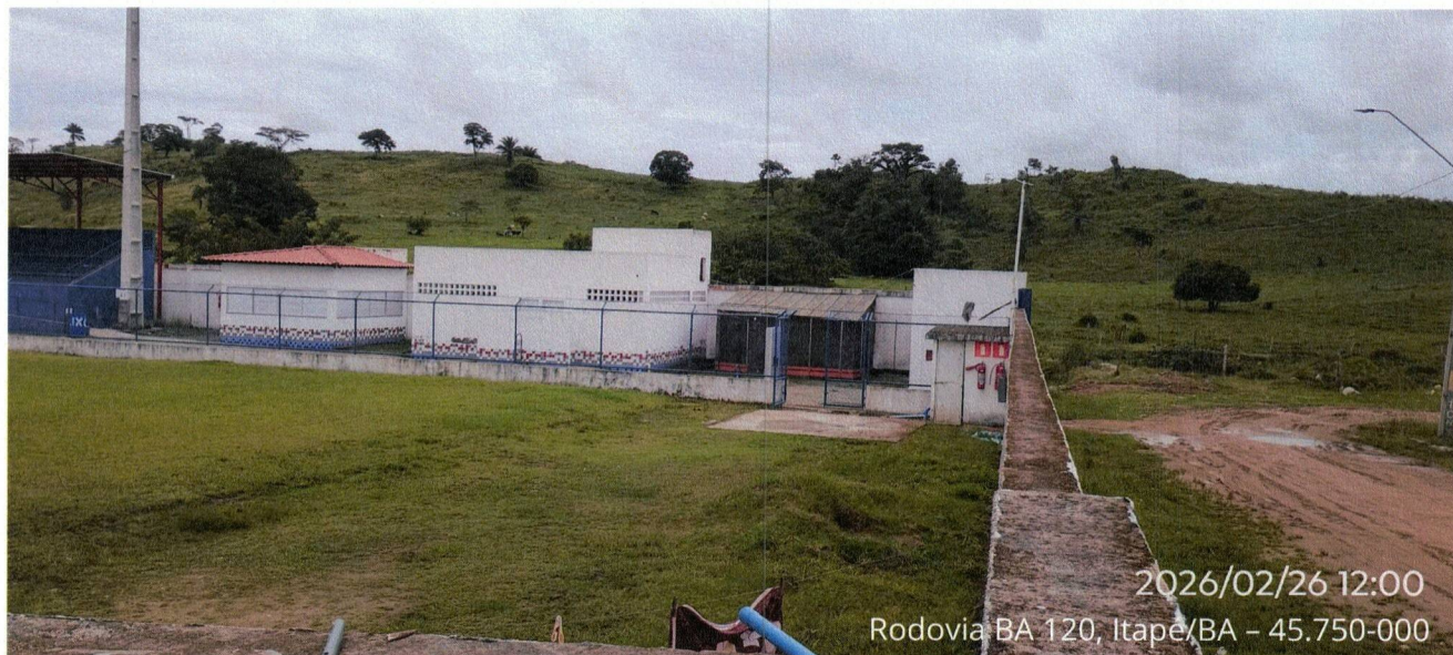
FOTO 03 – VISTA EXTERNA DO SANITÁRIO PÚBLICO
