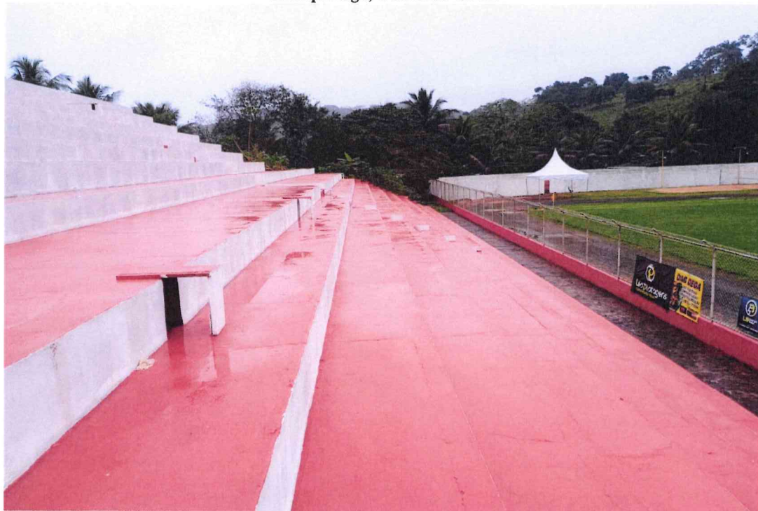
FOTO 03 – Vista da arquibancada
