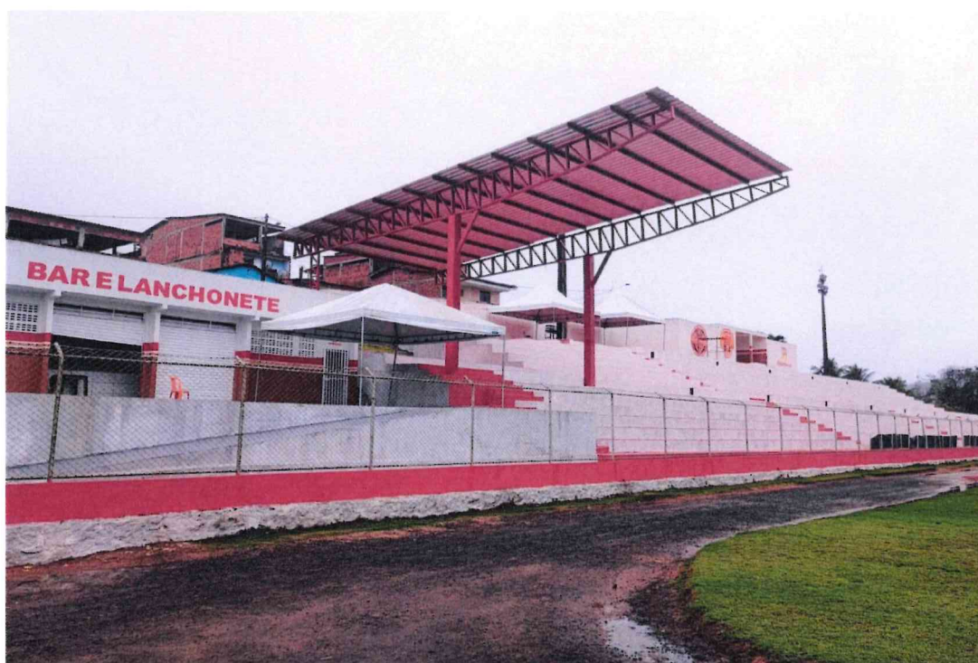
FOTO 02 – Vista lateral esquerda de estrutura da cobertura
