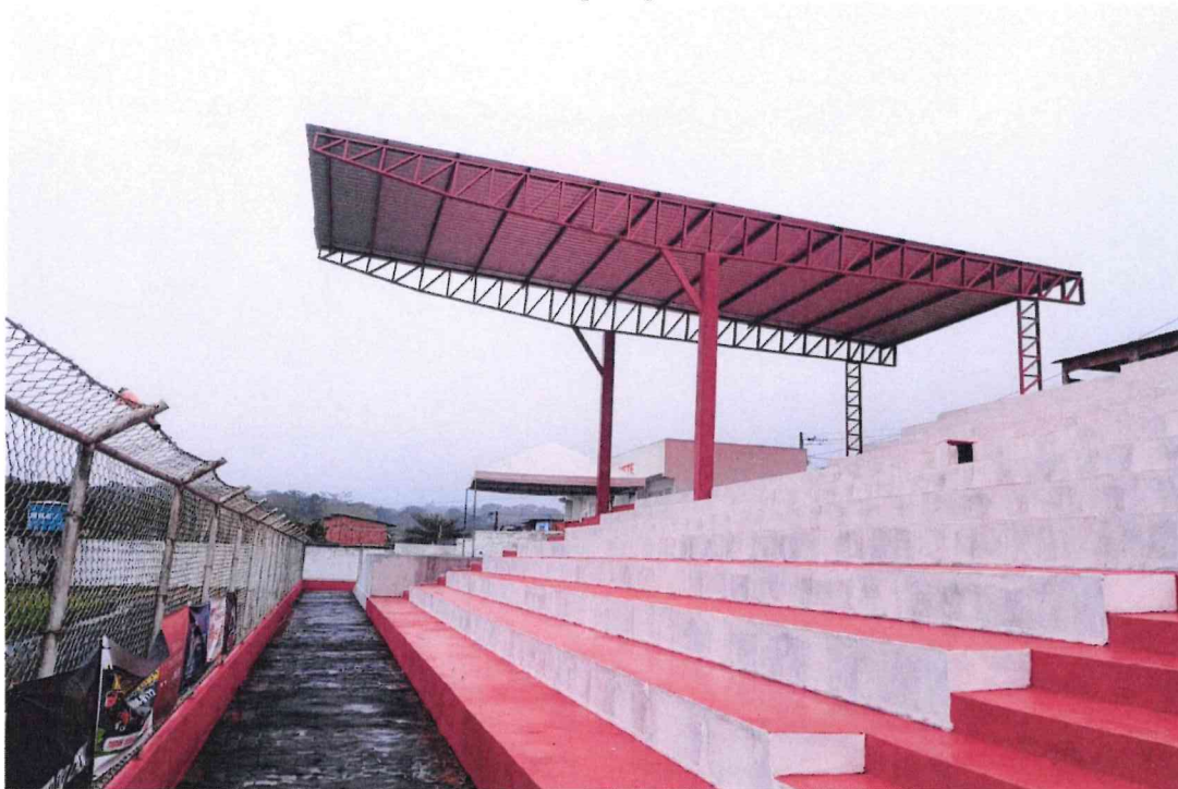
FOTO 01 – Vista lateral direita de estrutura da cobertura
