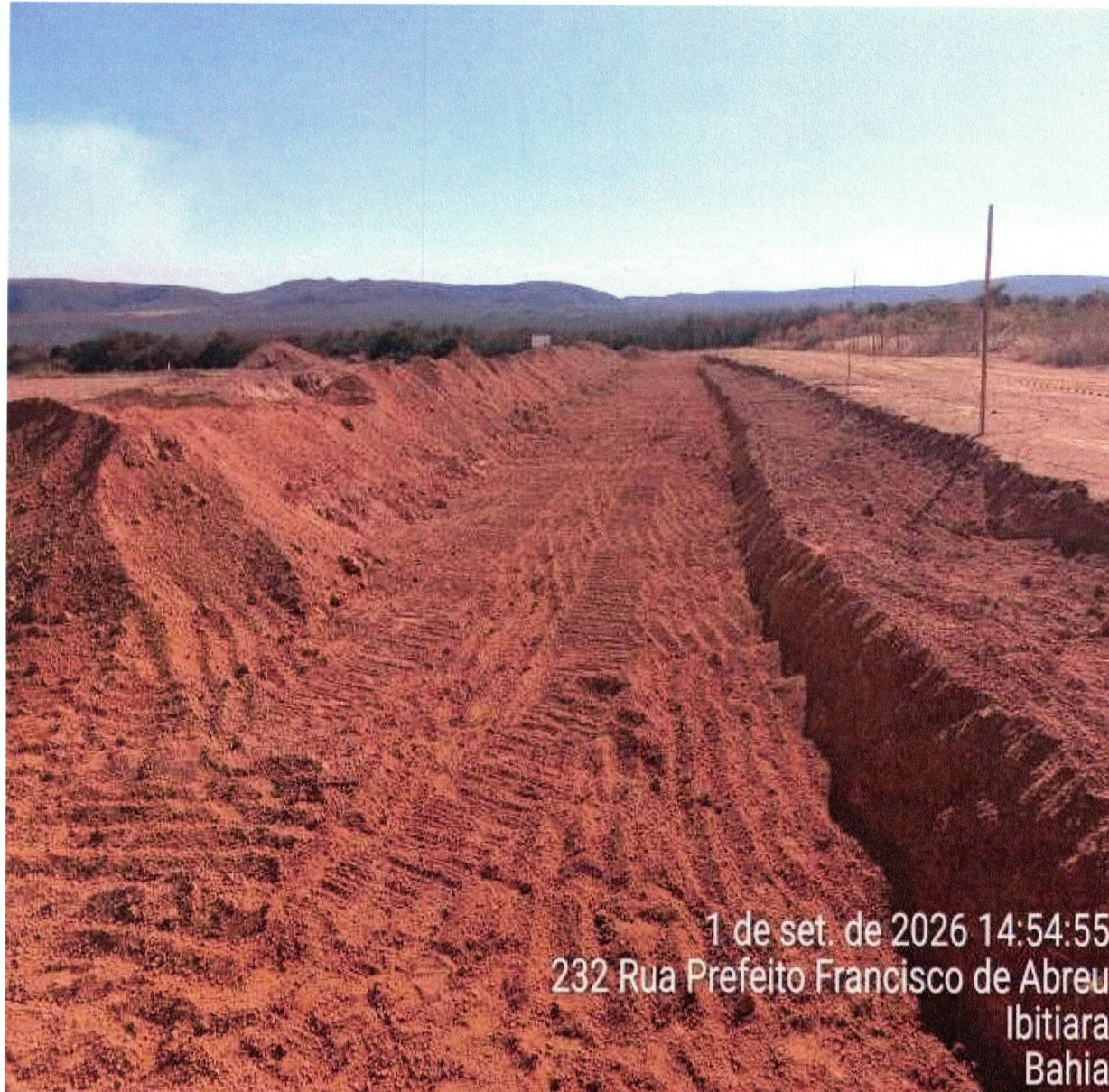
FOTO 01- VISTA DA MOVIMENTAÇÃO DE TERRA
