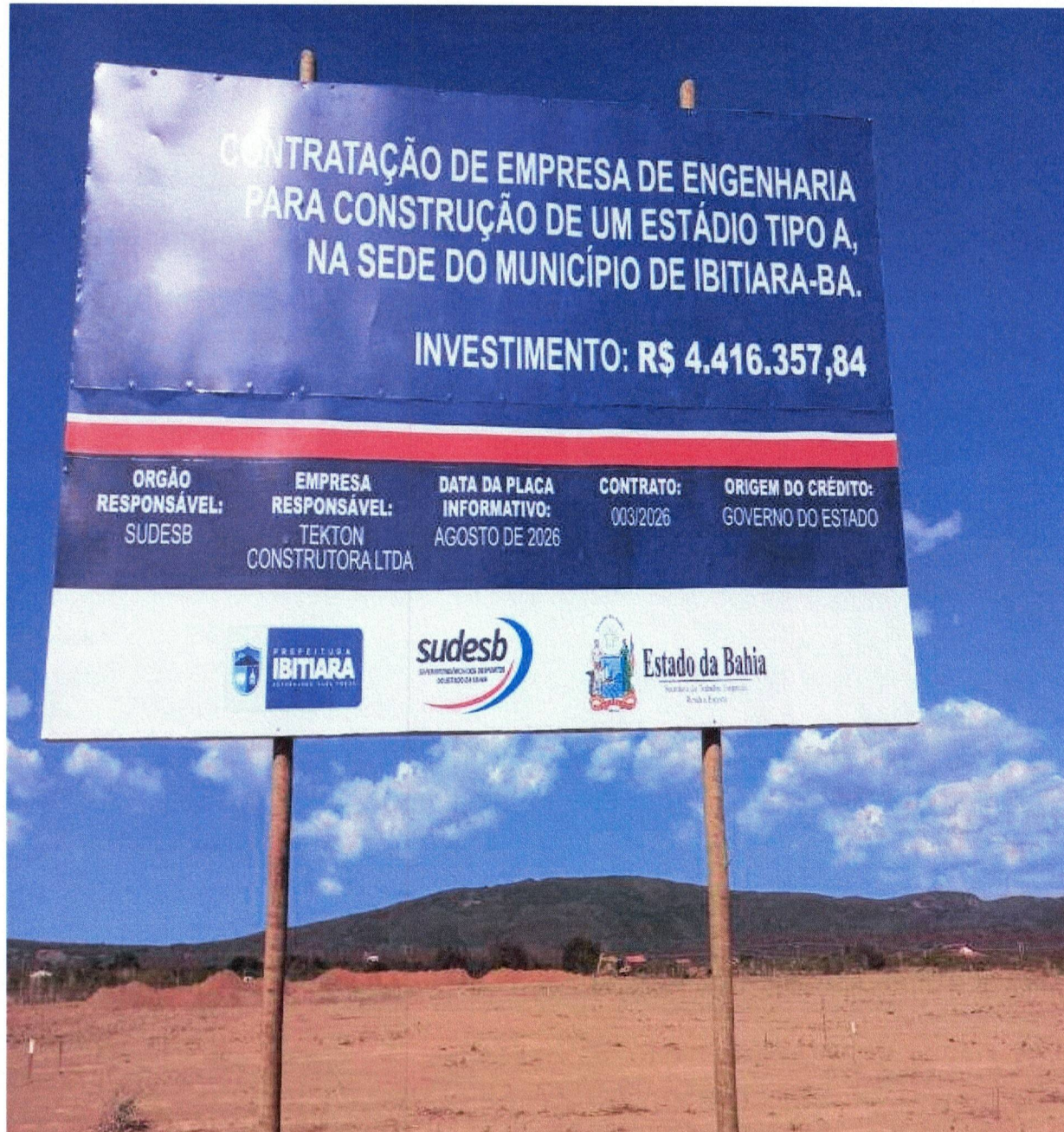
FOTO 02- VISTA DA PLACA DA OBRA
