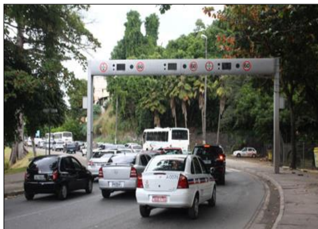
IMAGEM 6 – Radar (equipamento localizado no poste).
