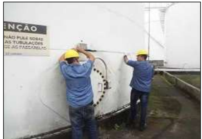
IMAGEM 12 - Tanque de Armazenamento à esquerda. Especialista Realizando Procedimento para Arqueação à direita.
