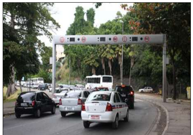
IMAGEM 6 – Radar (equipamento localizado no poste).
