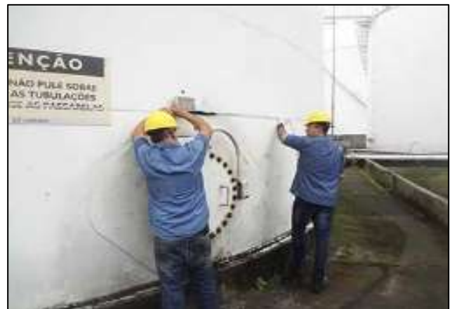
IMAGEM 12 - Tanque de Armazenamento à esquerda. Especialista Realizando Procedimento para Arqueação à direita.
