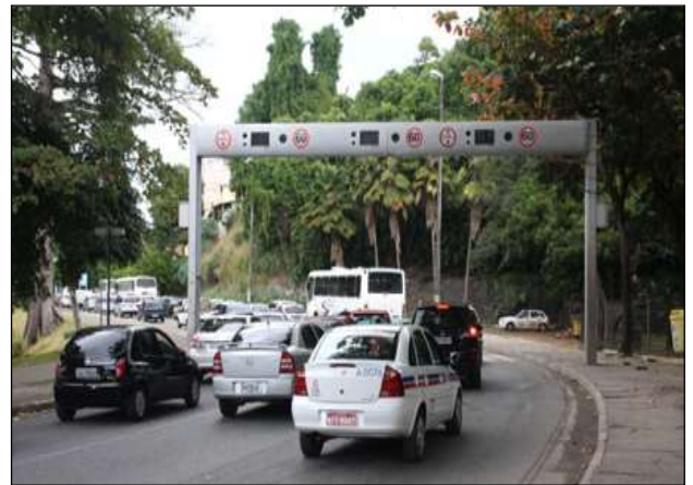
IMAGEM 6 – Radar (equipamento localizado no poste).
