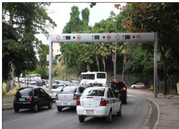
IMAGEM 6 – Radar (equipamento localizado no poste).
