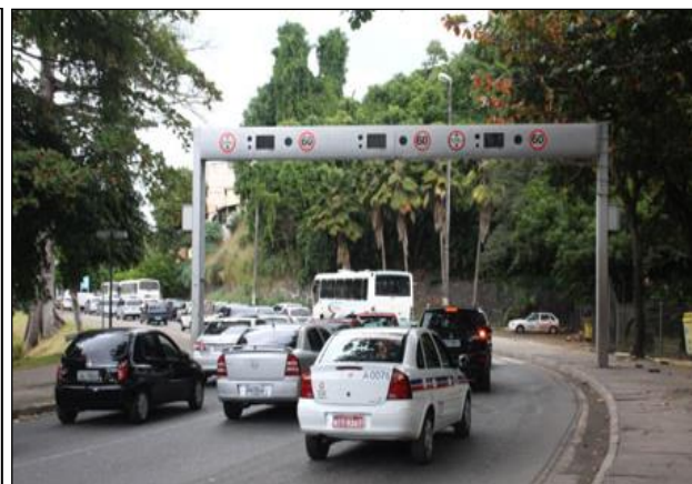
IMAGEM 6 – Radar (equipamento localizado no poste).
