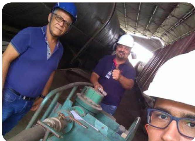
Manutenção de vagões-tanque para ferrovia Centro-Atlântica S.A.
