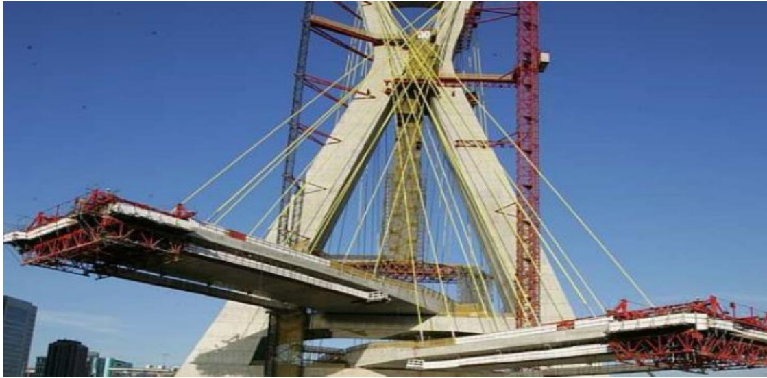
Fotografia 8 – Exemplos da construção por aduelas e treliças móveis (1)
