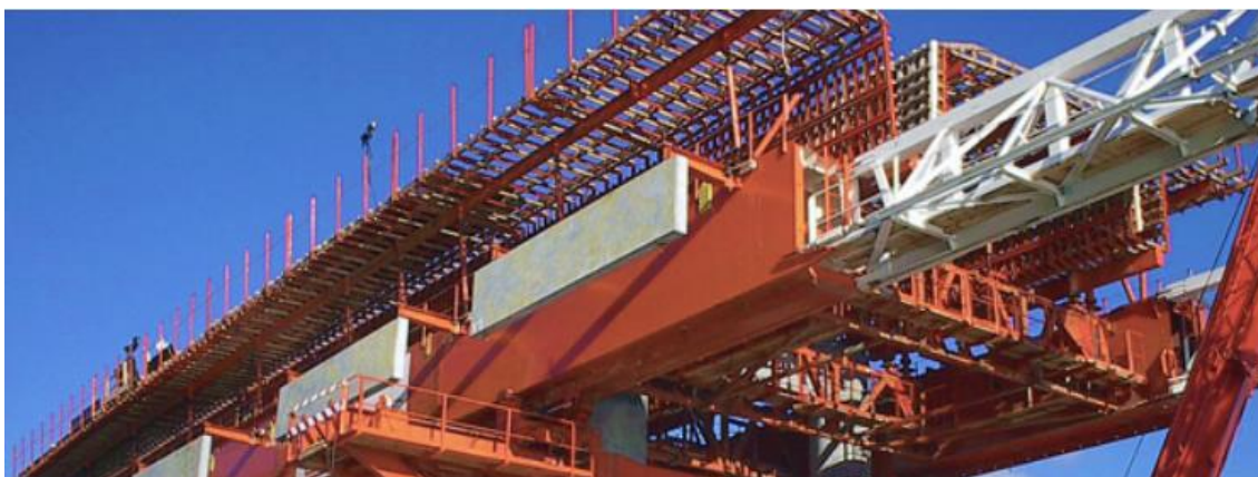
Fotografia 5 – Exemplos de construção com recurso a equipamentos MOVABLE SCAFFOLDING SYSTEM – MSS (1)
