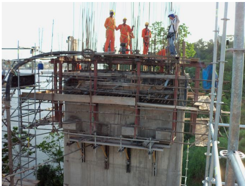
Fotografia 3 – Forma deslizante para construção do pilar
