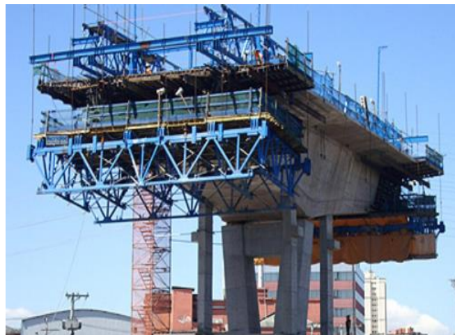
Fotografia 10 – Exemplos da construção por aduelas e treliças móveis (3)
