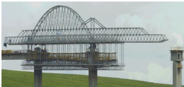
Fotografia 7 – Exemplos de construção com recurso a equipamentos MOVABLE SCAFFOLDING SYSTEM – MSS (3)
