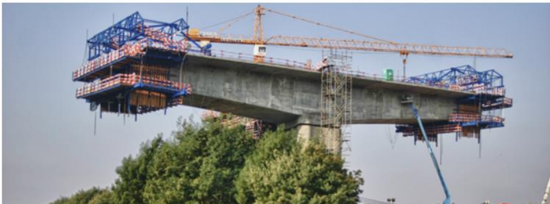
Fotografia 9 – Exemplos da construção por aduelas e treliças móveis (2)
