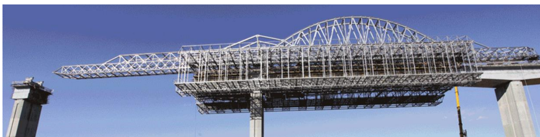
Fotografia 6 – Exemplos de construção com recurso a equipamentos MOVABLE SCAFFOLDING SYSTEM – MSS (2)
