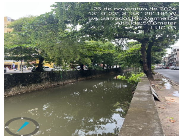
Figura 22. Ponto LUC 03, situado no rio Lucaia, Rua Lucaia.
