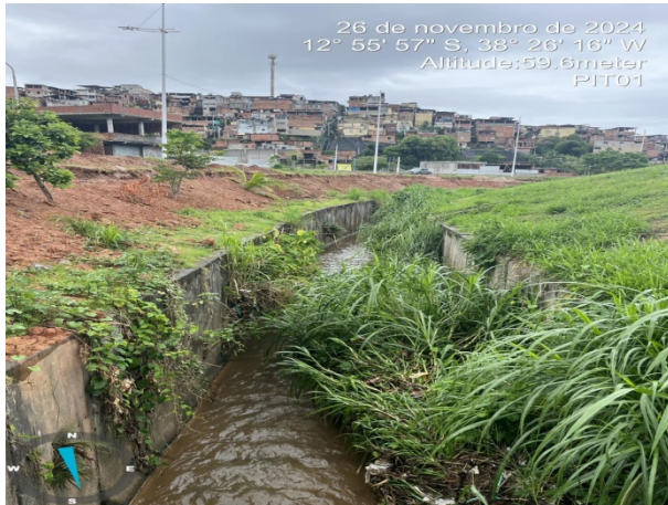
Figura 14. Ponto PIT 01, situado no rio Pituáçu, Av. Gal Costa.
