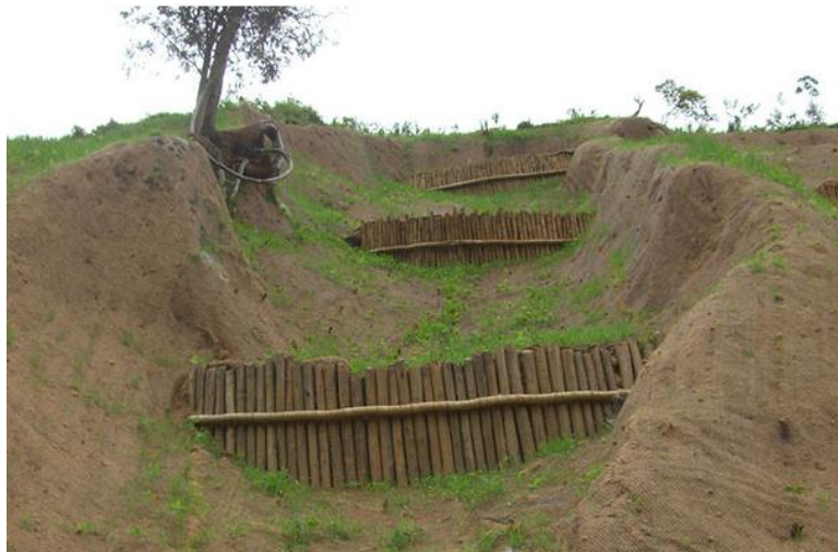
Figura 4-22 Aplicação de paliçada de madeira em talvegue.
