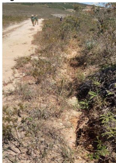
Figura 1b – Erosão do solo devido à ausência de um sistema de drenagem
