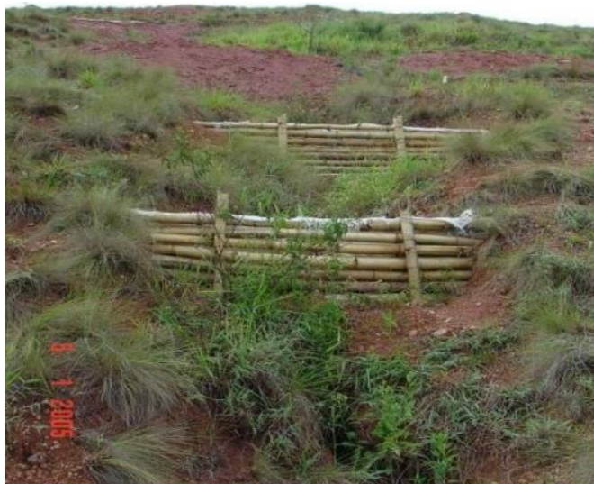
Figura 4-21 Aplicação de paliçada de bambu e sacos de rafia
