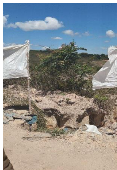
Figura 17d - Processo erosivo próximo da via de acesso.
