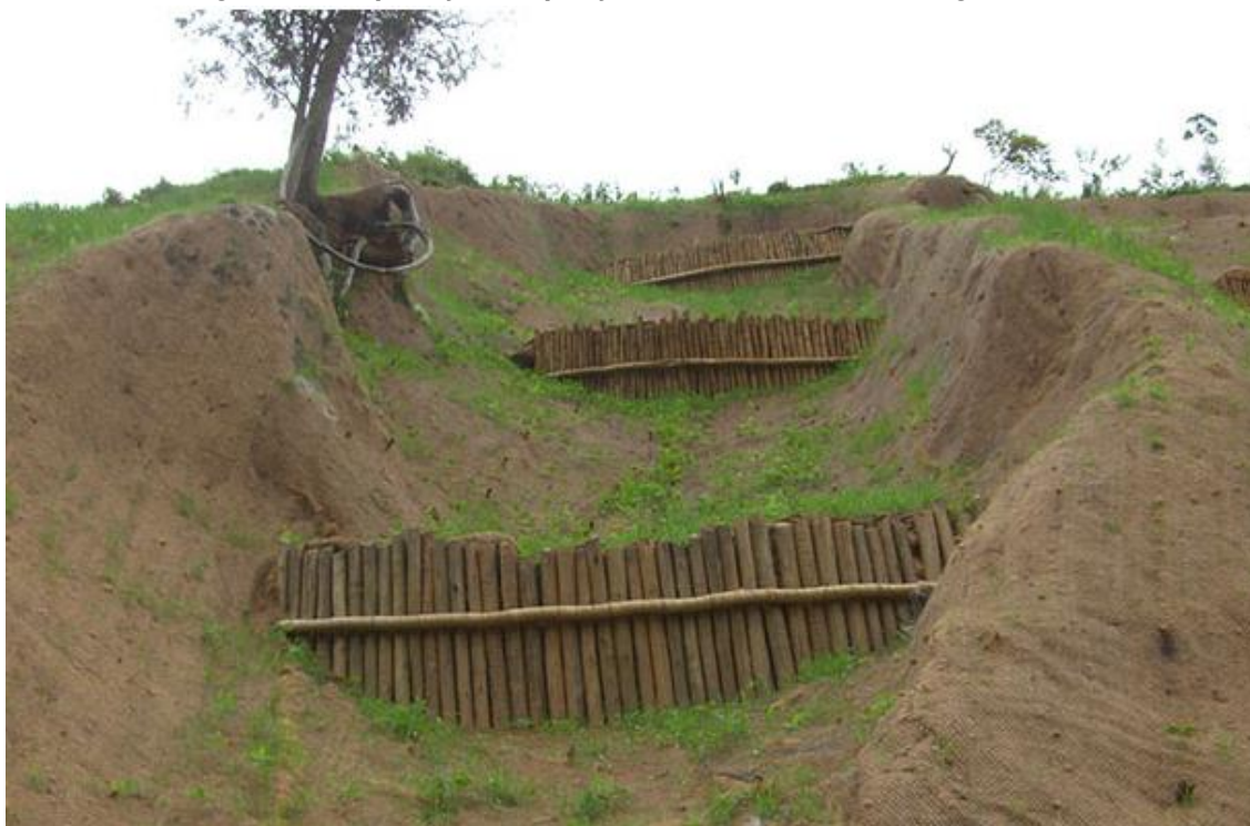
Figura 4-17 Aplicação de paliçada de madeira em talvegue ravinado
