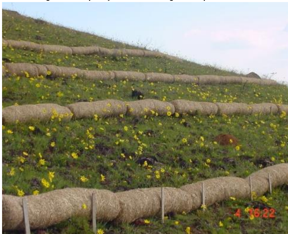
Figura 4-15 Aplicação da bermalonga em superfície inclinada.
