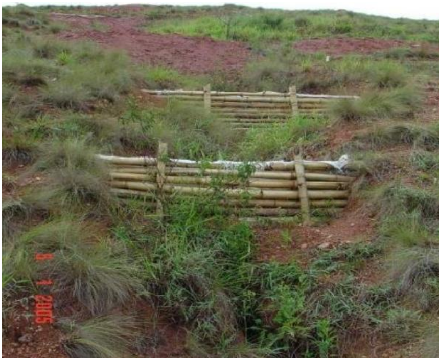
Figura 4-16 Aplicação de paliçada de bambu e sacos de rafia
