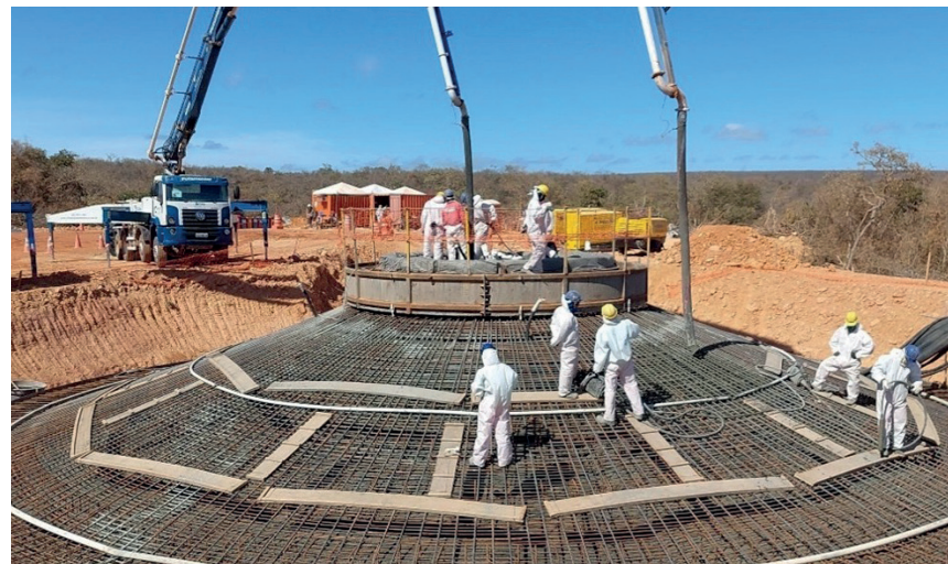
Fundação do aerogerador
