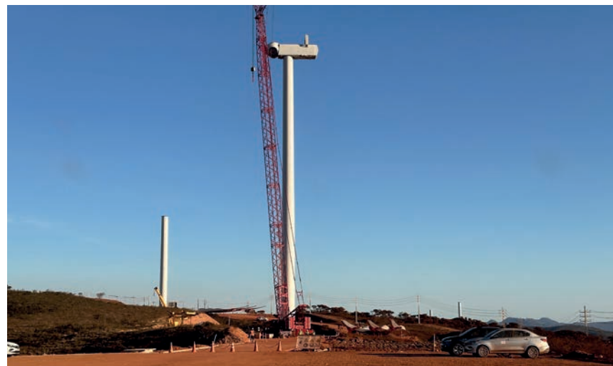
Montagem dos componentes do aerogerador
