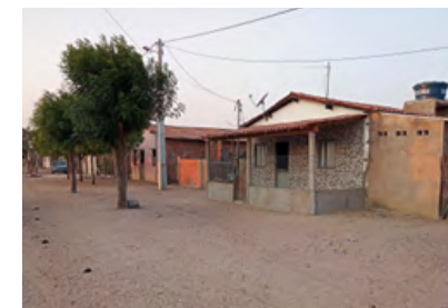
Rede elétrica em Estreito II
