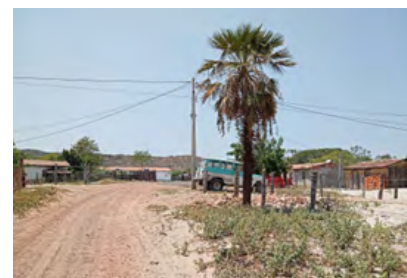
Rede elétrica em Buriti
