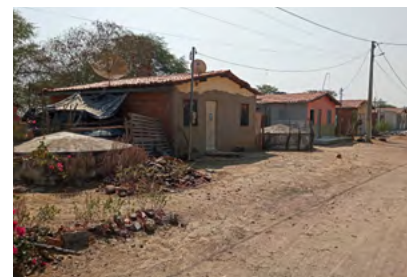
Rede elétrica em Gado Bravo
