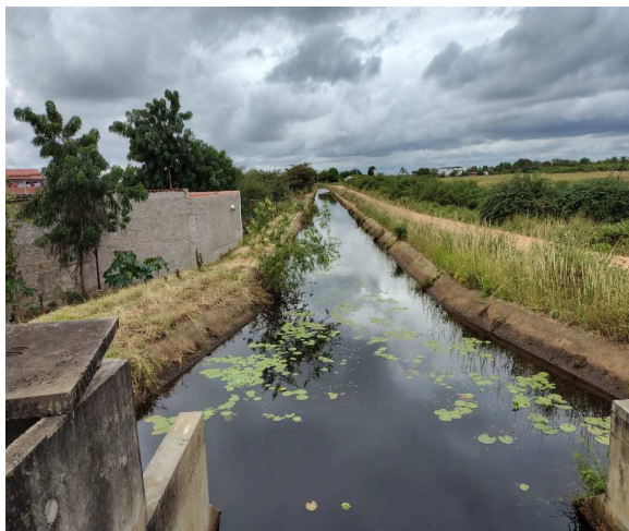
Canal de irrigação no DIPN
