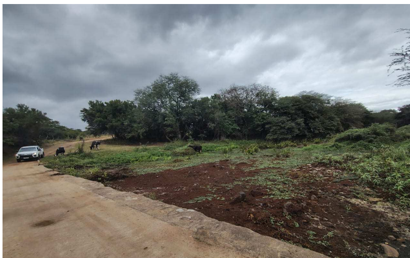
Barragem de Aroeira assoreada (Município de Queimadas)
