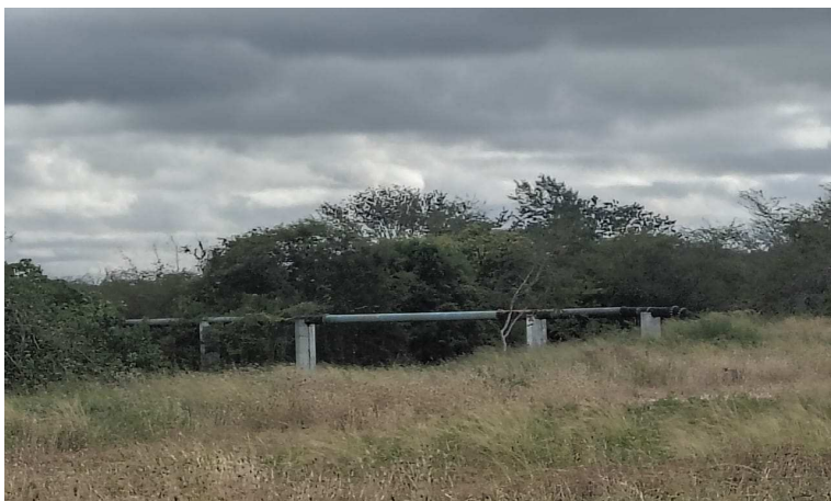
Adução que sai da Barragem de Ponto Novo para Pedras Altas
