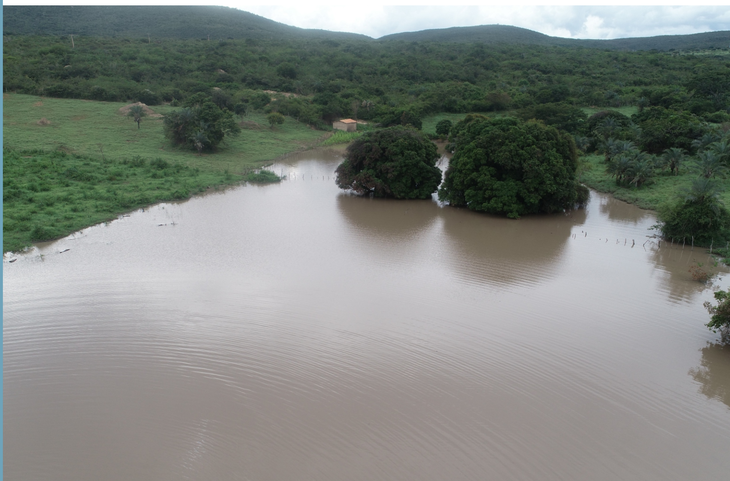
Barramento do Córrego São Lourenço que abastece a comunidade de Cocal
