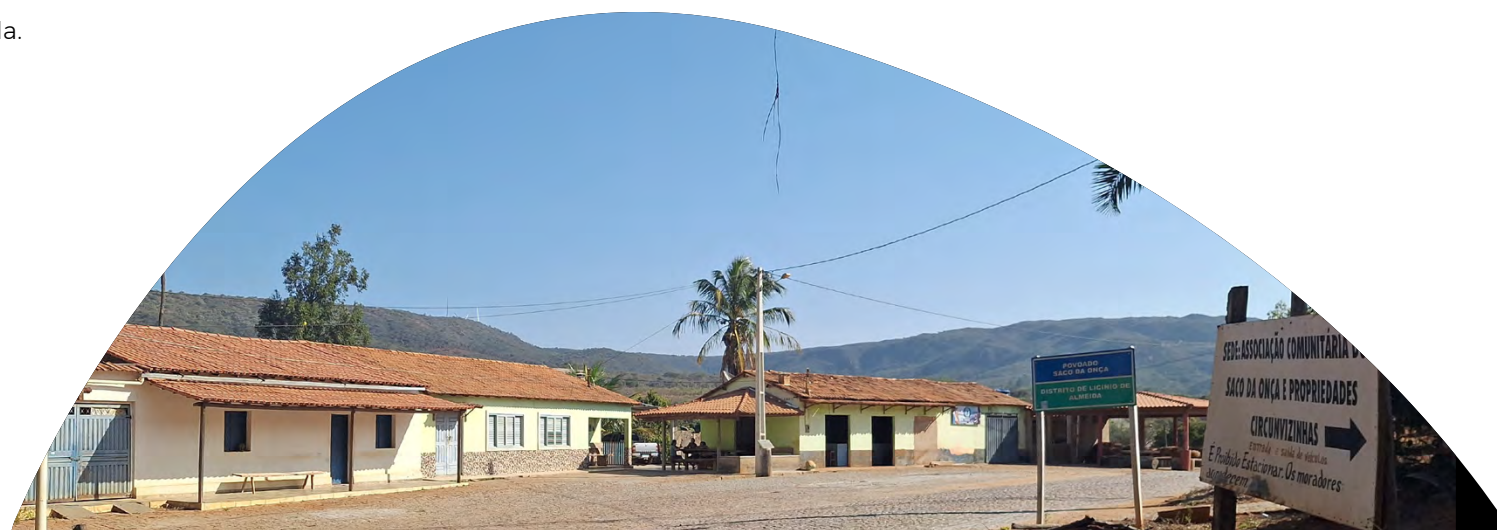
Vista da comunidade de Saco da Onça
