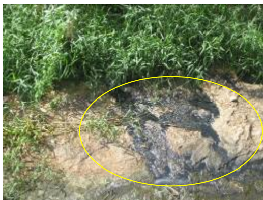
Figura 8.2.69: Lançamento de efluentes na margem direita do rio, à montante do ponto CON-PEX-400 – Rio do Peixe
