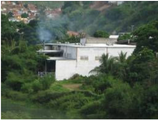
Figura 8.2.26: Indústria de laticínio na margem esquerda do rio, à montante do ponto CON-CON-550 – Rio de Contas
