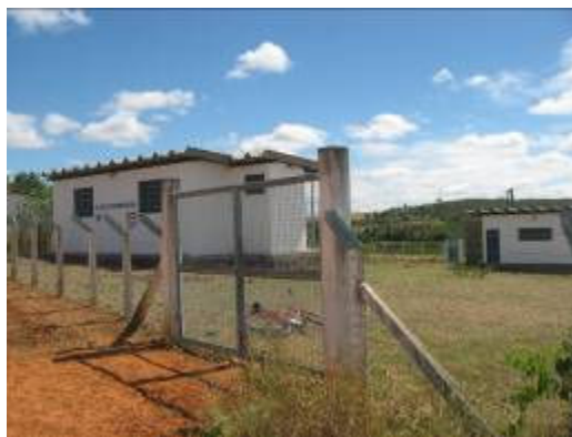
Figura 8.2.37: Estação de Tratamento de Água – ETA, na margem direita do rio, à montante do ponto CON-CON-400 – Rio de Contas
