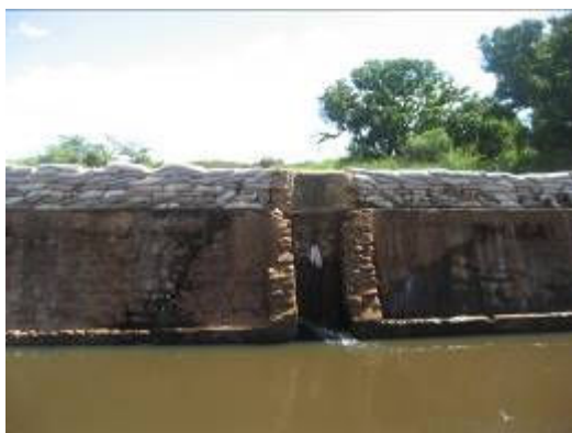
Figura 8.2.19: Barragem de Caiçara da Barra no ponto CON-BRU-500 – Rio Brumado
