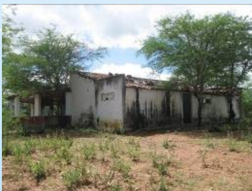
Figura 8.2.43: Construção abandonada próxima ao ponto ITP-CRC-050 - Rio Cariaça
