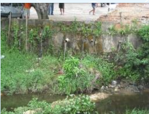
Figura 8.2.26: Lançamento de efluente no entorno do ponto ITP-ITM-050 - Rio Itapicuru Mirim
