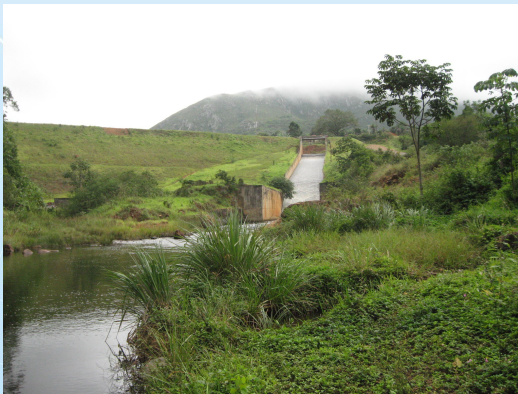
Figura 8.2.14: Aspecto das águas do ponto ITP-AIP-050 - Rio Aipim
