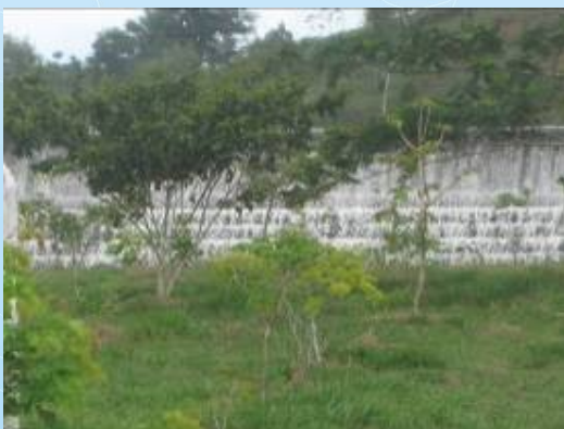
Figura 5.2.14: Barramento da EMBASA, à montante do ponto RCS-DON-100 – Rio da Dona
