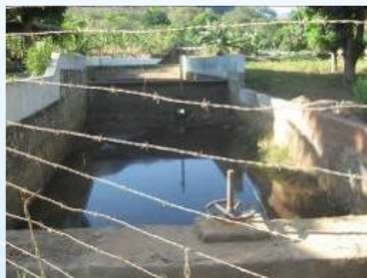
Figura 8.2.28: Represa de água à jusante, na margem esquerda do ponto ITP-ITM-050 – Rio Itapicuru-Mirim
