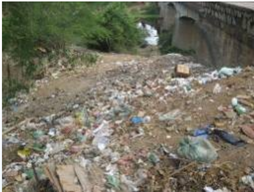
Figura 8.2.34: Resíduos sólidos próximos ao ponto ITP-ITP-330 – Rio Itapicuru
