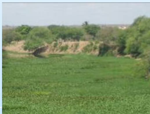
Figura 8.2.33: Parte da margem direita erodida à jusante do ponto ITP-ITP-330
