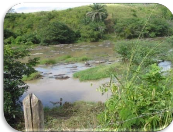
Foto 3.2: Seção transversal ao rio Colônia no local selecionado para o eixo do barramento. Vista tomada da ombreira esquerda
