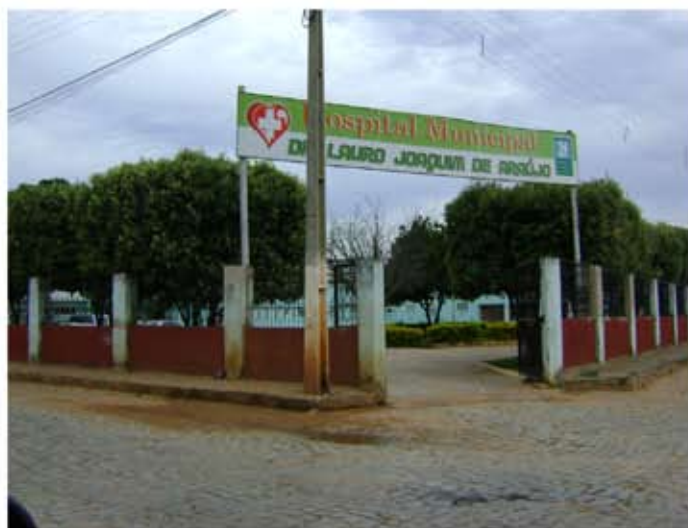
FOTO 139 - HOSPITAL MUNICIPAL DE CORRENTINA 2009.
