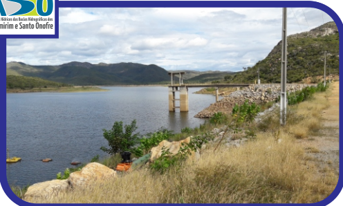
BARRAGEM DE ZABUMBÃO Paramirim
