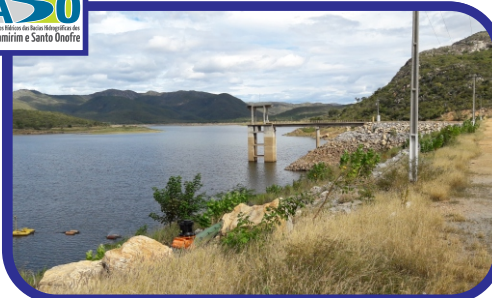
BARRAGEM DE ZABUMBÃO Paramirim
