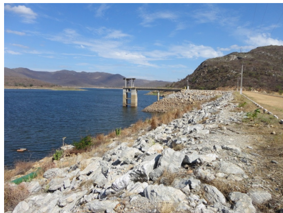
Foto 3.5 - Talude de jusante e torre de tomada d'água da barragem de Zabumbão
