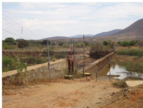
Foto 3.8 - Barragem do Rio da Caixa
