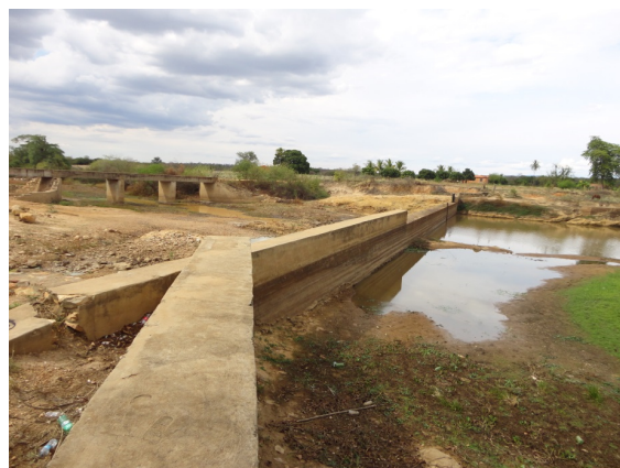
Foto 3.9 - Barragem de Santa Terezinha em Macaúbas
