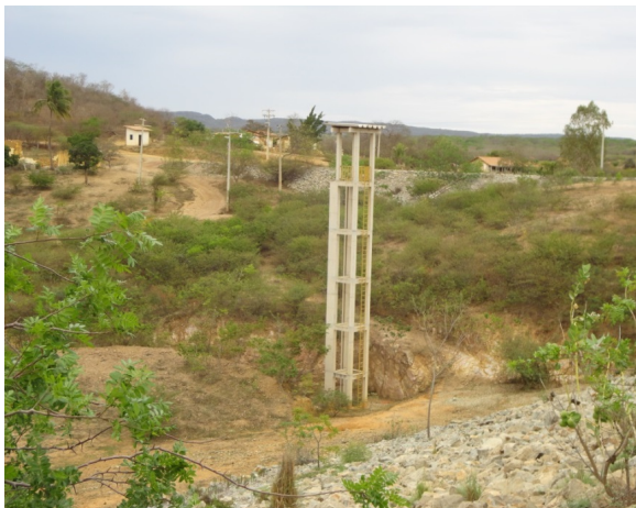
Foto 3.7 - Reservatório seco na torre de tomada d'água
