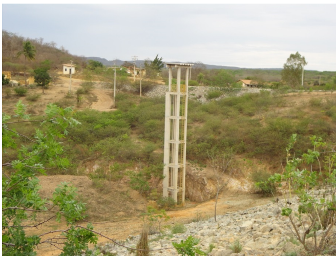
Foto 3.6 - Reservatório seco na torre de tomada d'água
