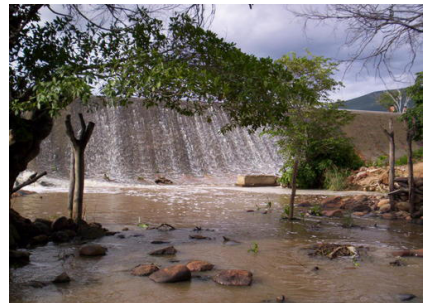
Barragem no rio dos Remédios, em Ibiajara
