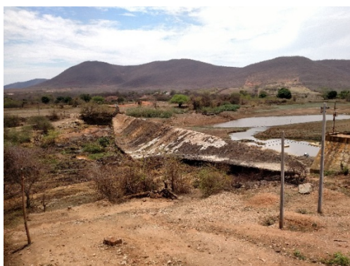
Foto 3.13 - Barramento no rio da Caixa, um dos principais afluentes do rio Paramirim (captação para Rio do Pires)
