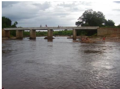
Ponte da BA-153 sobre o rio da Caixa
