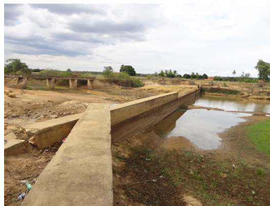
Foto 3.8 - Barragem de Santa Terezinha em Macaúbas
