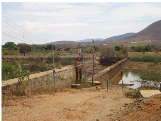
Foto 3.7 - Barragem do Rio da Caixa
