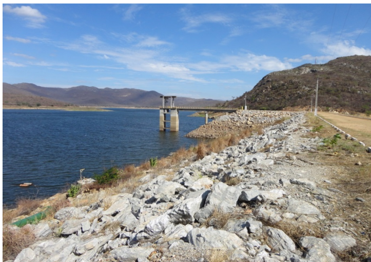
Foto 3.4 - Talude de jusante e torre de tomada d'água da barragem de Zabumbão
