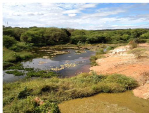
Foto 2.11 - Vista a jusante da barragem de Barra do Mendes
