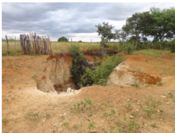
Foto 2.7 - Estruturas de colapso
