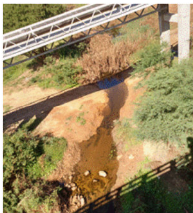
Foto 2.14 - Vista do rio Verde sob a ponte da BA-052
