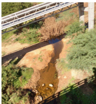
Foto 3.16 - Vista do rio Verde sob a ponte da BA-052
