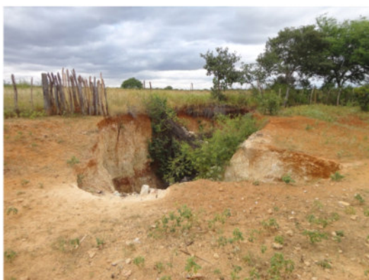
Foto 3.9 - Estruturas de colapso
