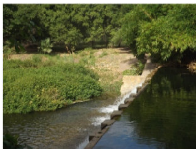
Barragem de Maravilha
