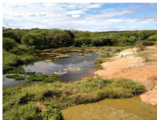
Foto 3.13 - Vista a jusante da barragem de Barra do Mendes
