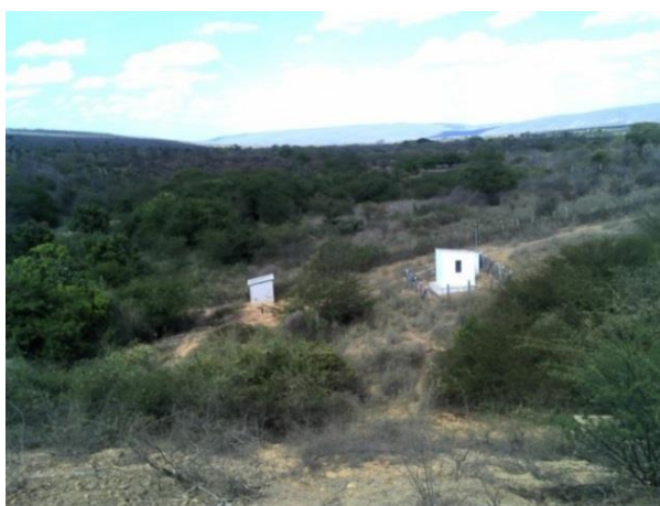
Figura 10.25 – Vista do trecho a jusante da barragem Delfino, onde se pode visualizar dois poços profundos que atendem ao SAA da localidade
