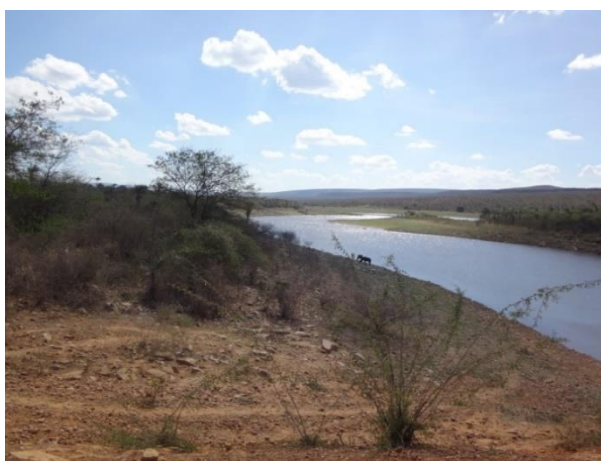
Figura 10.21 – Vista parcial do lago da barragem de Taquarendi
