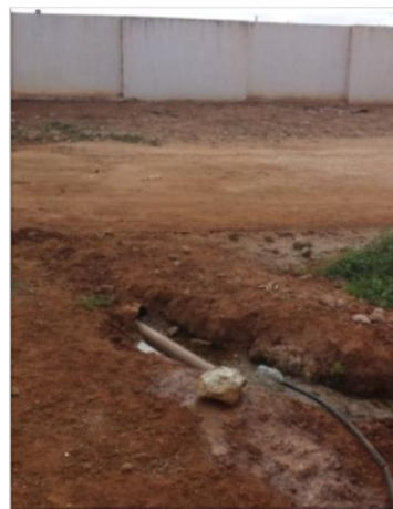
Figura 10.13 – Detalhe do efluente da estação dessalinizadora de Ouroilândia, escoamento diretamente para o lago da Barragem de Ouroilândia
