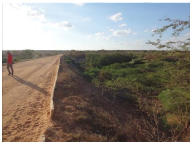
Figura 10.10 – Vista do talude de jusante da barragem de Ouroilândia, onde se observa a vegetação existente
