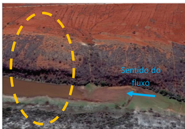
Figura 10.6 – Porção mais a montante do reservatório da Fazenda Tamboril. Nota-se a presença de carreamento de sedimentos proveniente de área de agricultura, com carreamento de sedimento para o reservatório
