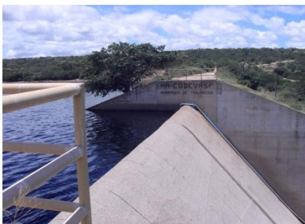
Figura 10.20 – Barragem de Taquarendi, crista do sangradouro
