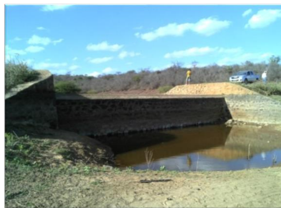
Figura 10.4 – Vista de montante do sangradouro da margem direita da Barragem de Tamboril
