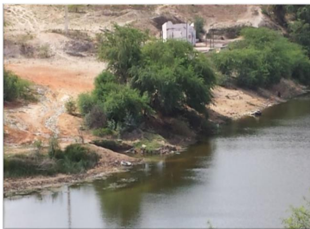
Figura 10.12 – Vista do talude de jusante da barragem de Ouroilândia, onde se observa a vegetação existente
