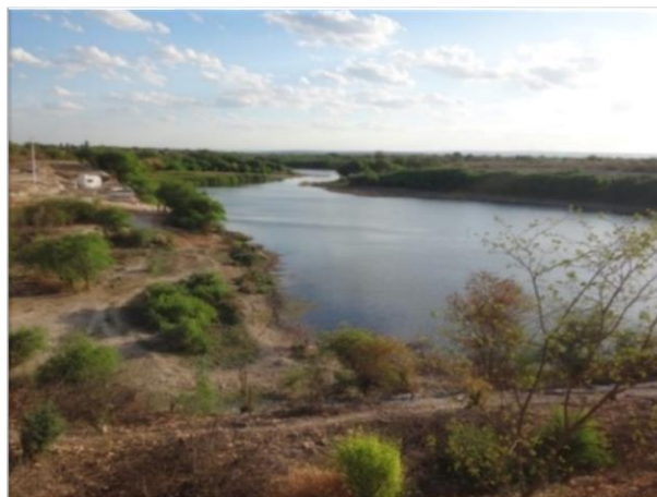
Figura 10.11 – Vista do lago da barragem de Ouroilândia, sendo a edificação à esquerda as ruínas de antigo balneário
