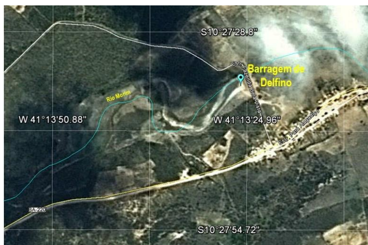
Figura 10.23 – Vista do espelho d'água da Barragem do Delfino
