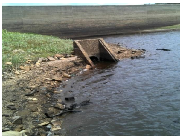
Figura 10.17 – Entrada da descarga de fundo da Barragem Caatinga do Moura, praticamente inoperante
