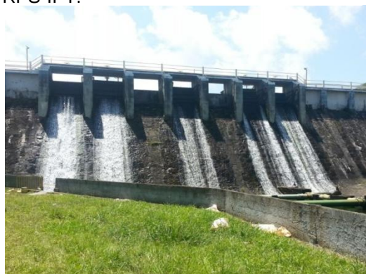
Figura 59: Barramento da água do ponto RPS-IPT.
