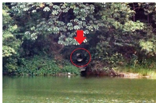
Figura 11: Conduto de drenagem de água pluvial encontrado na lagoa da CHESF.
