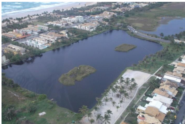
Figura 40: Foto aérea do ponto LGA-PFL.
