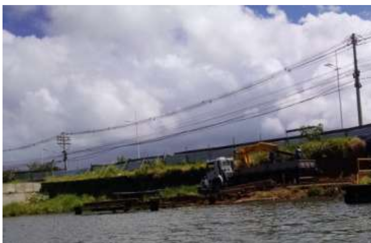
Figura 22: Obra sendo feita no entorno da lagoa FTC.
