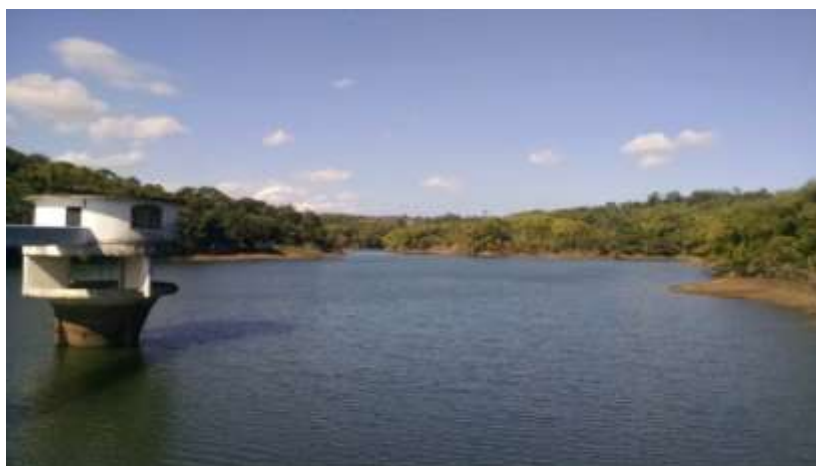
Figura 60: Barragem dos Macacos
