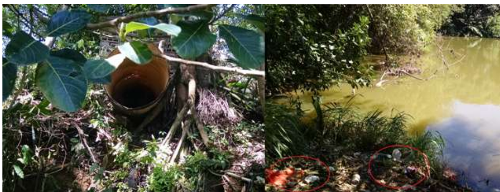
Figura 8: Conduto de escoamento de água pluvial e resíduos dispostos no entorno do manancial.
