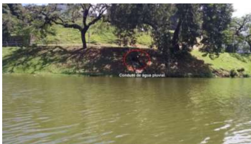
Figura 49: Conduto de água pluvial encontrado.
