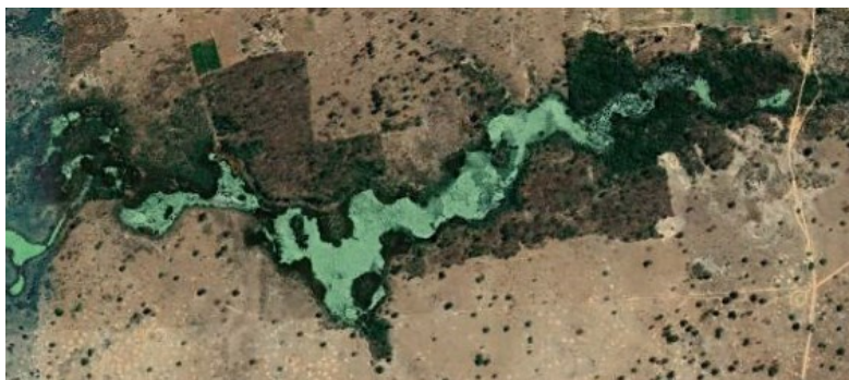
Barramento com indícios de eutrofização
