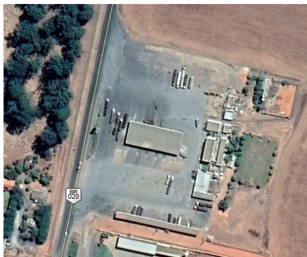
Figura 6.10 - Posto de Combustíveis em Roda Velha, à margem da BR-020 (observar presença de caminhões)
