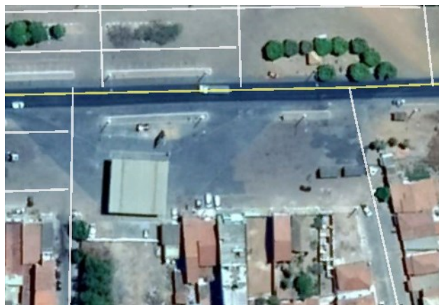
Figura 6.11 - Posto de Combustíveis na área urbana de Cristópolis
