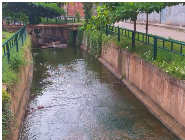
Figura 3. Ponto CAM 01 situado no trecho do rio Camarajipe no bairro de Alto do Cabrito.
