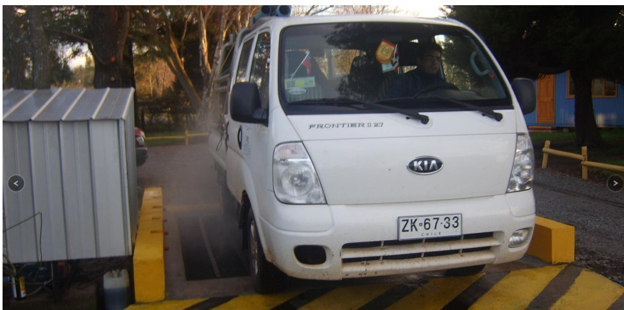
Figura 69 - Rodilúvio para limpeza de pneus e carroceria utilizado como medida sanitária no Chile para desinfecção e prevenção à disseminação de propágulos de espécies exóticas invasoras. Fonte: http://www.cirelchile.cl/web/productos.html (2024).
