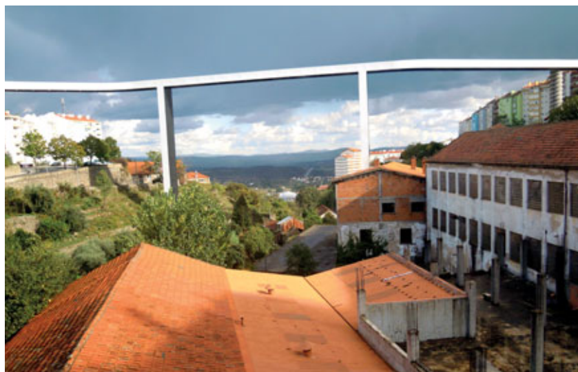
A mais alta ponte de pedestre de Portugal (21out 2019)
