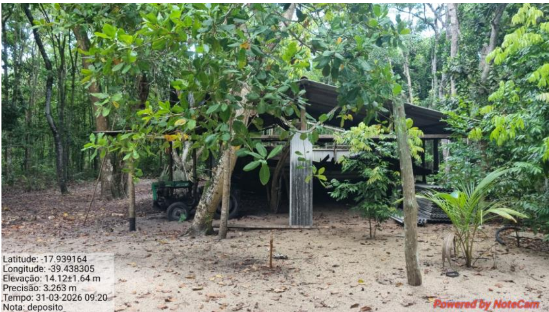
ID 15 - Galpão com depósito de materiais, veículos e ferramentas. Dimensões estimadas: 14,20m x 8,10m.
