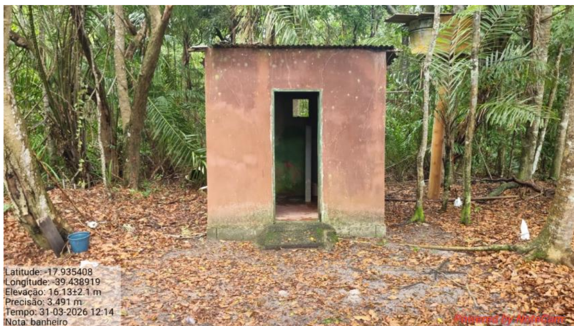
ID 4 – Banheiro com chuveiro para apoio aos seguranças na entrada principal. Dimensões aproximadas: 2,70m x 3,20m.
