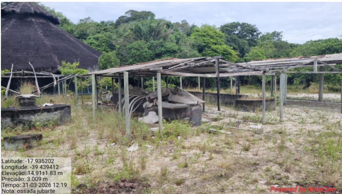
ID 2 - Galpão para disposição de ossada de Baleia Jubarte. Dimensões aproximadas: 14,40m x 19,80m.
