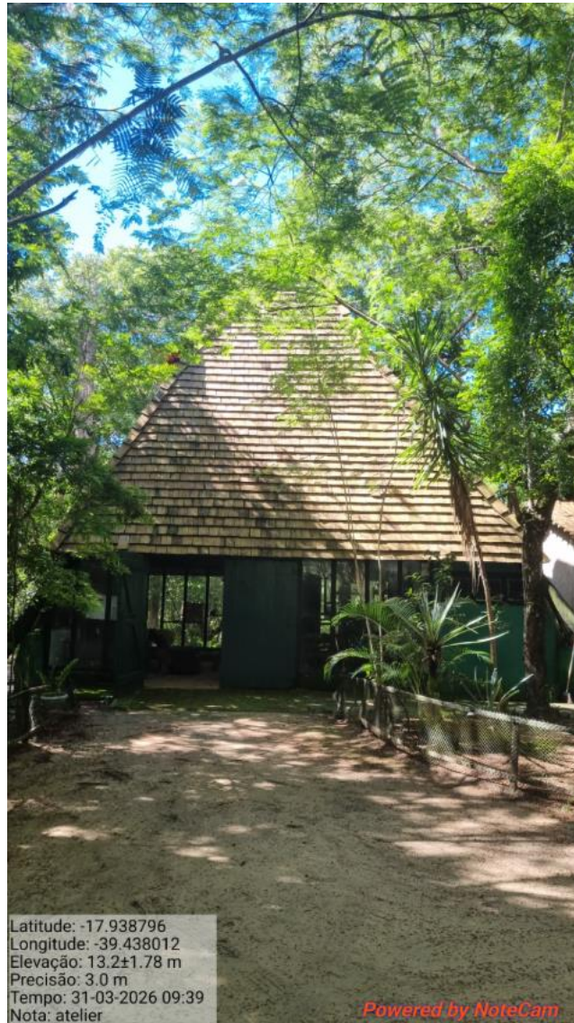
ID 9 – Atelier de Frans Krajcberg, com quarto no andar superior, banheiro e sala de revelação fotográfica no térreo. Dimensões estimadas: 12,20m x 12,20m.
